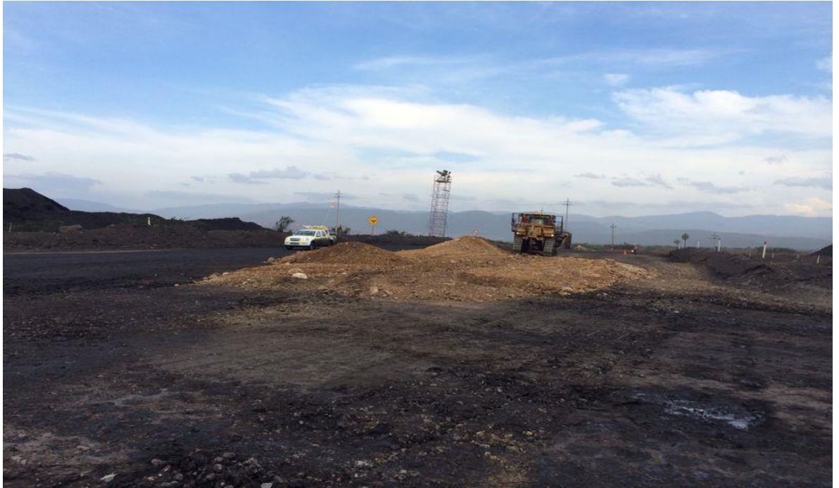
Figura 11. Reparación de vías con material estéril.
