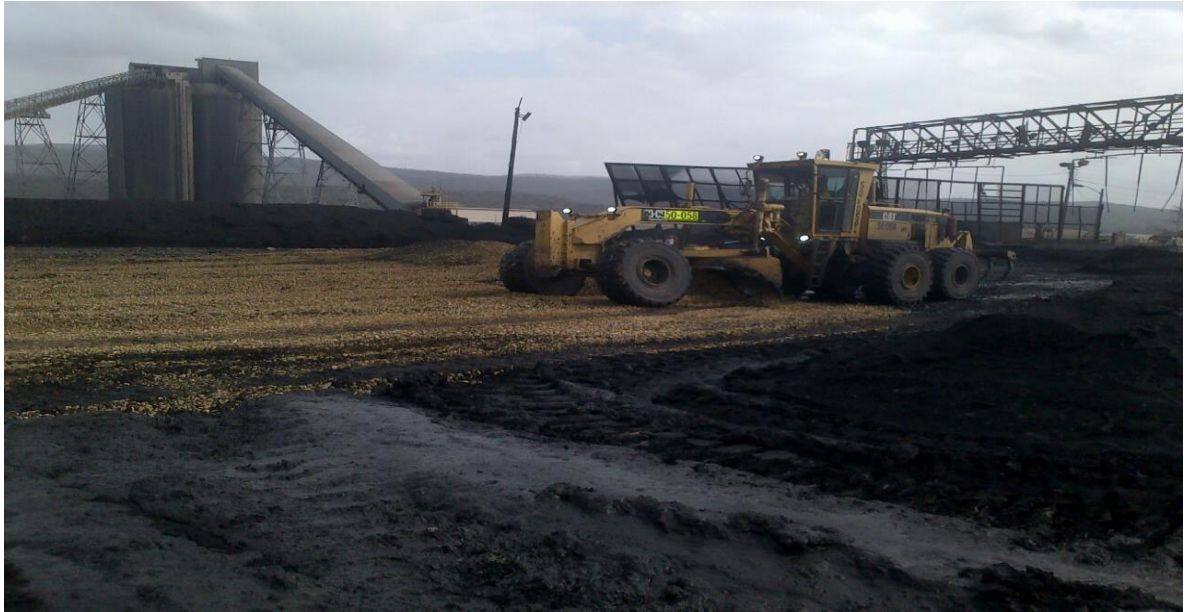
Figura 16. Motoniveladora nivelando material de la vía.
