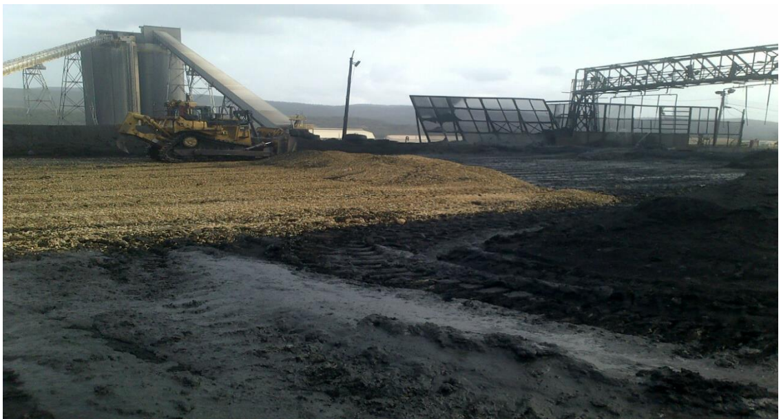
Figura 15. Tractor de oruga extendiendo material de reparación.
