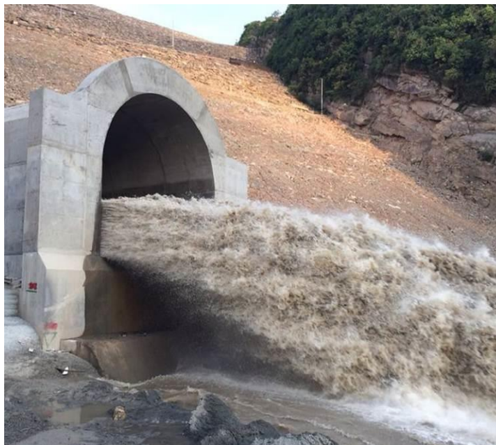
Figura 9. Portal de salida de descarga de fondo, que garantiza el caudal ecológico durante el llenado del embalse Fuente: Galería Avances de obra Junio 2014 ISAGEN http://www.isagen.com.co/nuestra-empresa/gestion-de-proyectos/proyecto-sogamoso/avance-de-obras/ 13 julio de 2014
