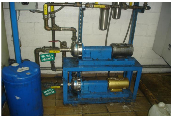
Fotografía.8. Moto bomba que envía la mezcla a las tijeras.
