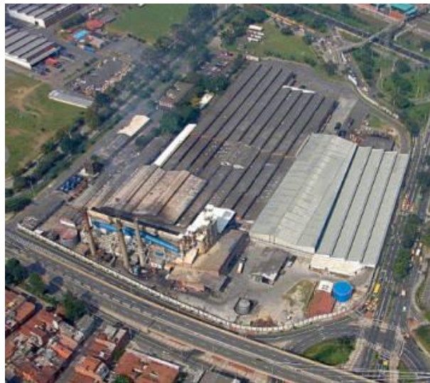
Fotografía 1. Toma aérea de la planta de Envigado.
