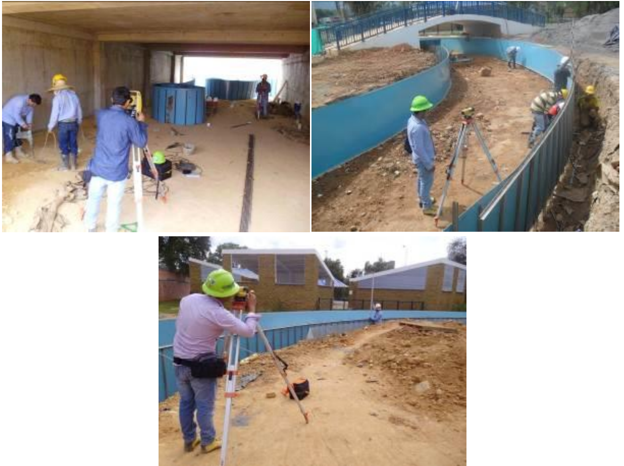
Imagen 4 localización y replanteo
