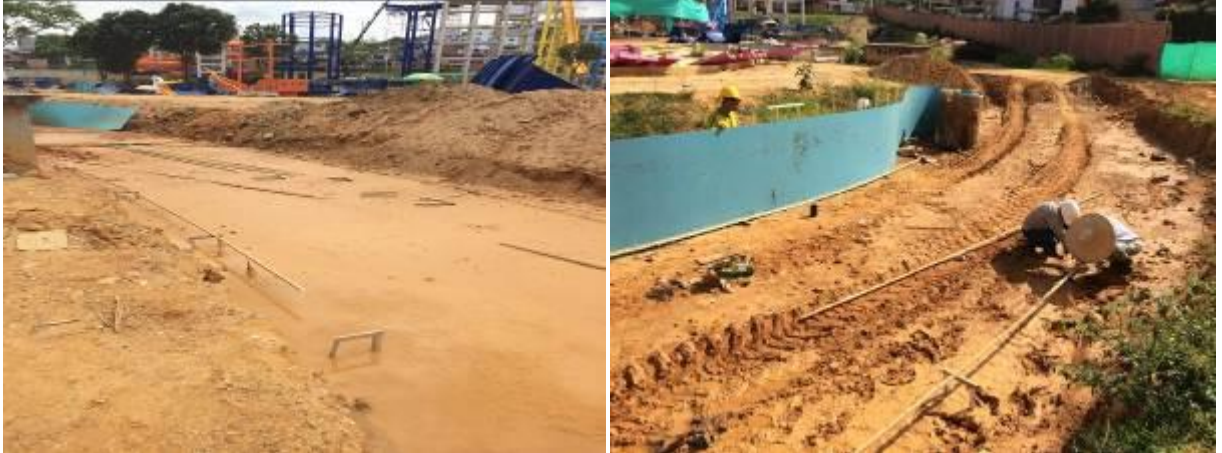
Imagen 10 Colocación ángulos y rieles
