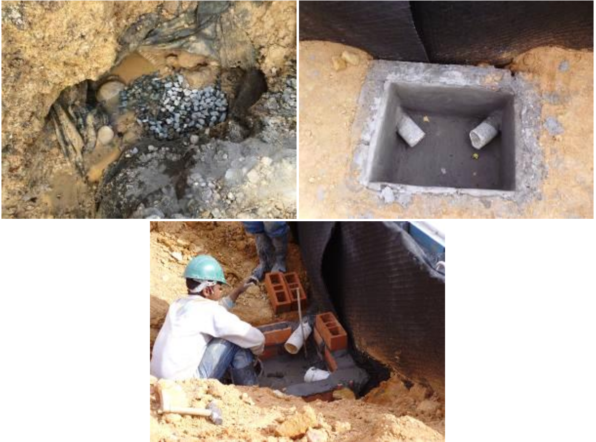
Imagen 9 construcción de filtro rio lento
