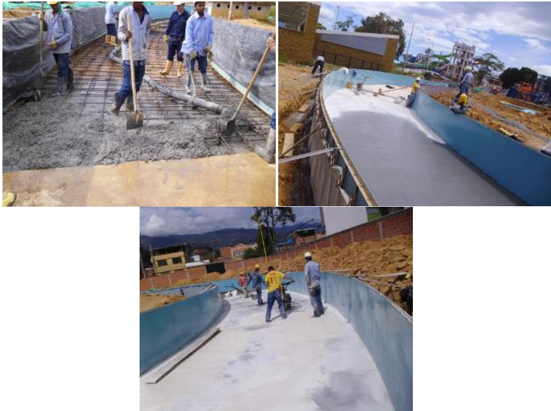
Imagen 14 Fundida placa en concreto de 4000 PSI
