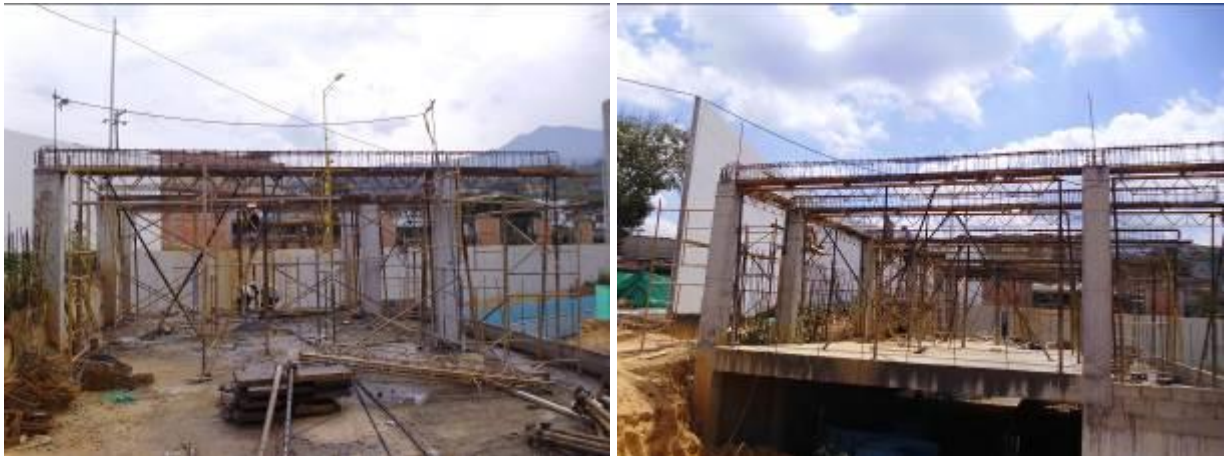
Imagen 26 Figurado de acero para la placa
