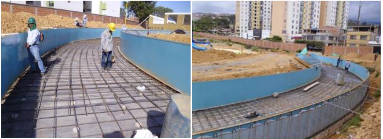
Imagen 13 Figurado del acero de refuerzo
