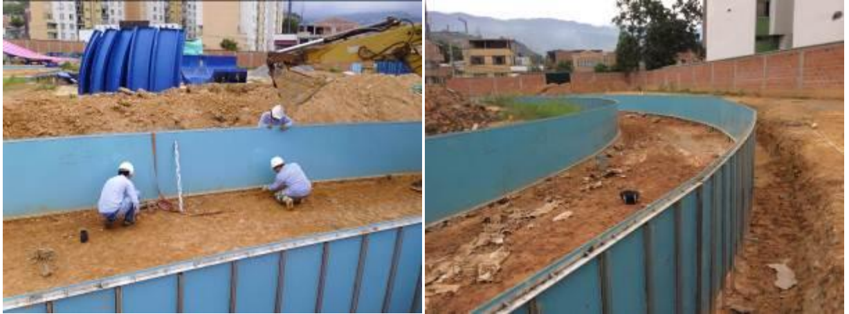
Imagen 11 Instalación de la pared
