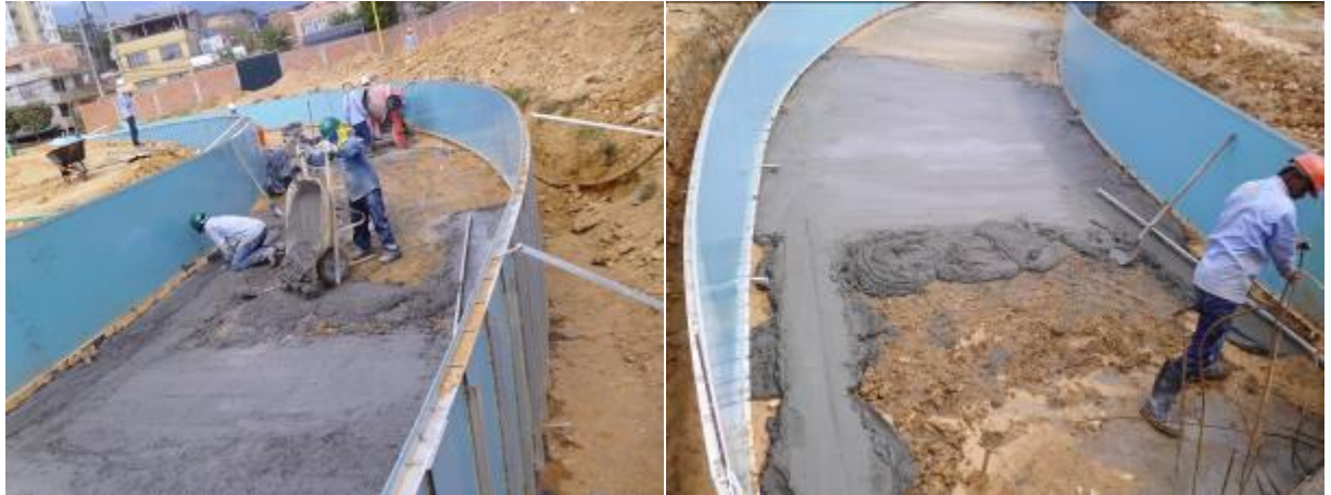
Imagen 12 Colocación solado de limpieza
