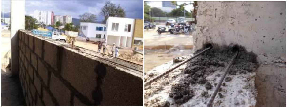
Imagen 28 Colocación mampostería estructural
