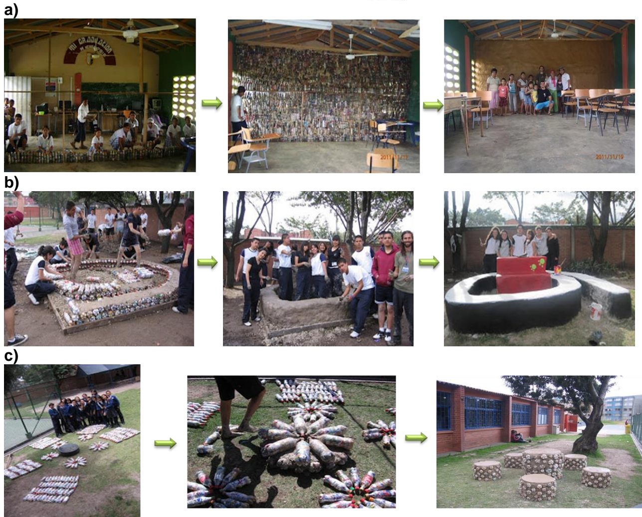
Figura 5: a) Puerto Libertador, Monte Líbano, Córdoba Construcción de un Muro para dividir un aula y hacer la sala de computadores. b) Banca en Forma de Espiral, GIMFA, Bogotá, c) Mesa Redonda, GIMFA, Bogotá
