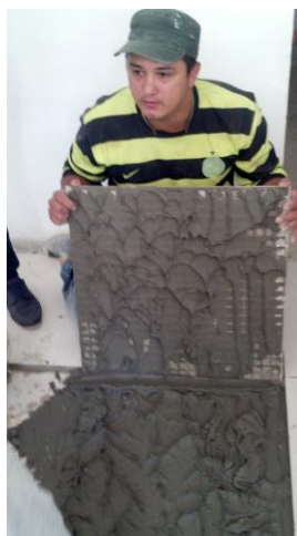
Foto 5. Cara inferior de la losa completamente adherida al mortero de pega.
