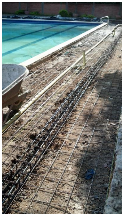
Foto 39. Instalación de malla electrosoldada para refuerzo en placa de terraza piscinas.
