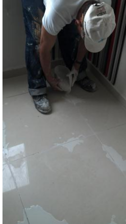
Foto 4. Mejoramiento de la adherencia del porcelanato al mortero de pega inyectando bindaboquilla con sikalatex.
