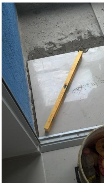
Foto 18. Nivelación de piso en área de balcón.
