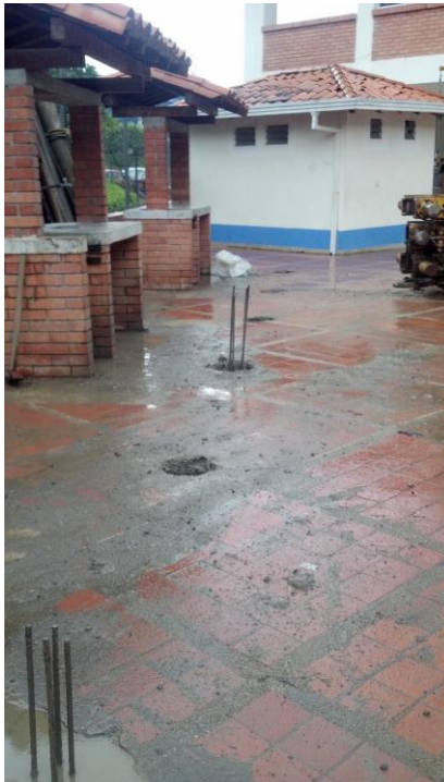
Foto 45. Micropilotes en zona de los BBQS.
