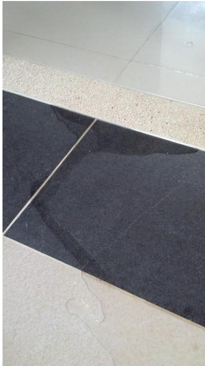
Foto 21. Nivel de piso punto fijo en contrapendiente desde la zona de circulación, hacia el inmueble.
