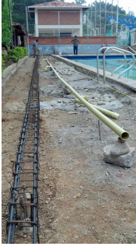
Foto 38. Instalación viga de amarre para los micro-pilotes y acometida sanitaria para los sifones.
