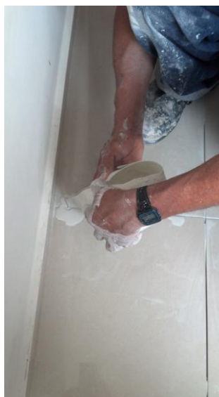
Foto 8. Aplicación de bindaboquilla con sikalatex en brechas.
