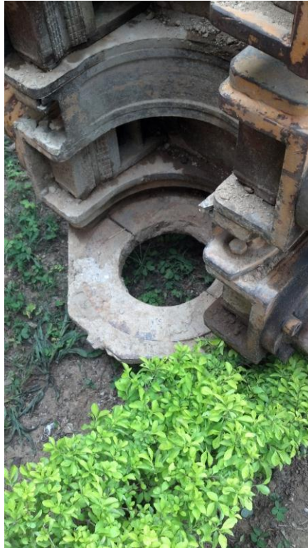
Foto 30. Localización in-situ para perforación de Micro-pilote.
