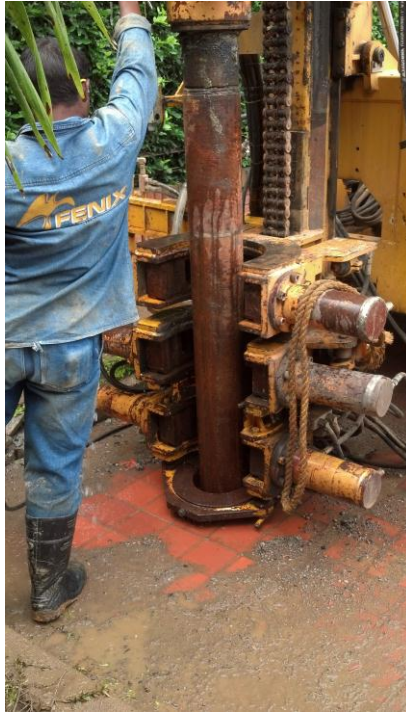
Foto 34. Maquina piloteadora en proceso de excavación.
