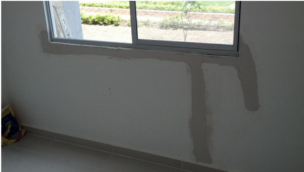
Foto 25. Reparación en filo de muro (vano de ventana) por filtraciones de agua-lluvia.
