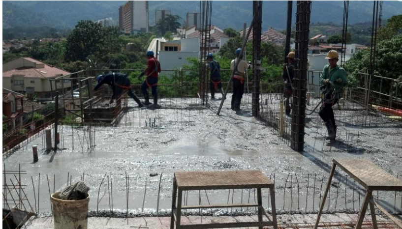
Foto 24. Fundida de placa de entrepiso
