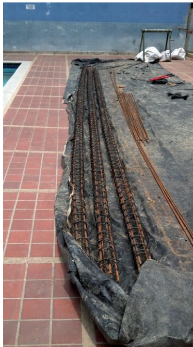
Foto 35. Armado de acero de refuerzo de micro-pilotes.
