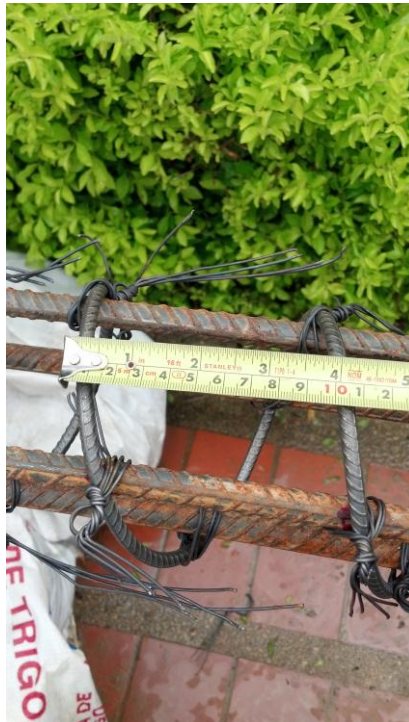
Foto 31. Espacio de estribos en acero de refuerzo de ¼". Estructura del micro-pilote.
