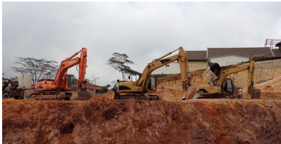
Imagen 1: Fotografía de las Retroexcavadoras presente en obra
