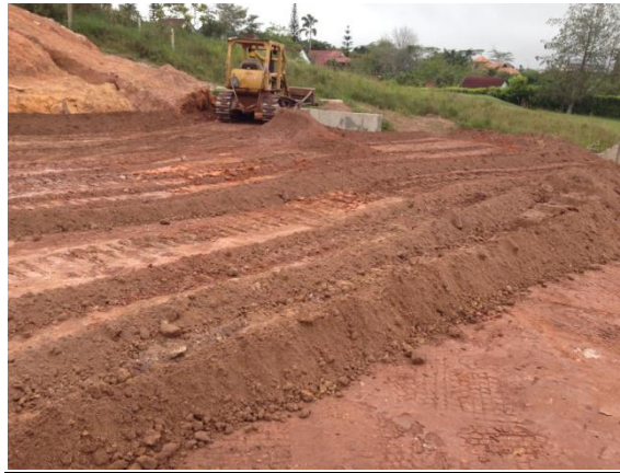
Imagen 3: Fotografía del Buldócer D4D extendiendo material.
