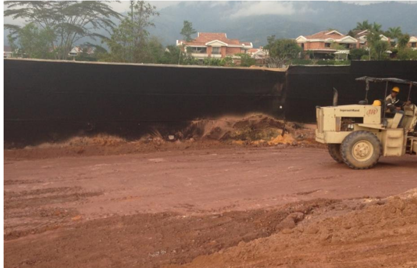
Imagen 4: Trabajos de Compactación de capa.
