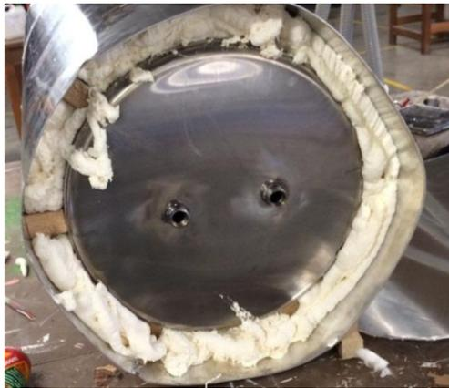
**Figura 19.** Aplicación del aislante térmico, fuente: autores del proyecto
