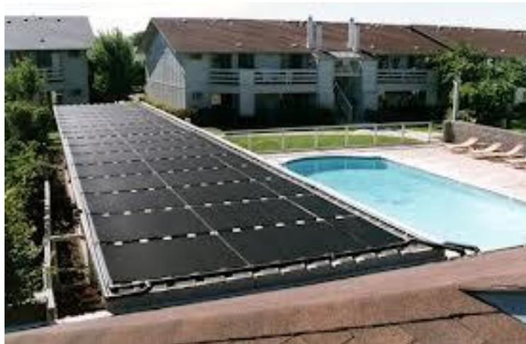
**Figura 8.** Colector de placa plana sin cubierta<sup>5</sup>.
