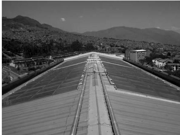
**Figura 9.** Colectores solares del Hospital Pablo Tobón Uribe, Medellín, en operación desde mediados de los ochenta (240 m<sup>2</sup> de colectores, tanque de 20 m<sup>3</sup>, no visible).<sup>22</sup>
