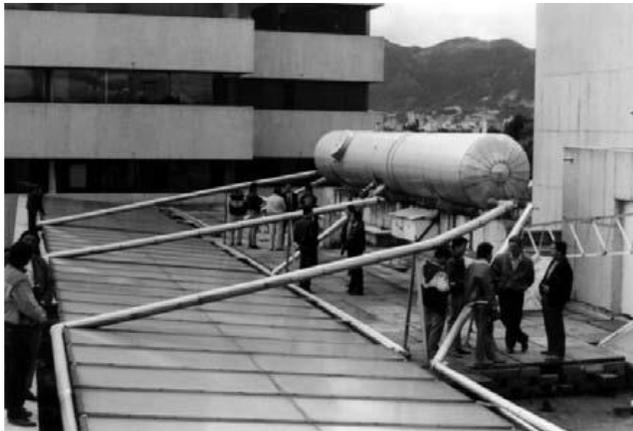
**Figura 8.** Calentador de la cafetería de la antigua Empresa de Energía de Bogotá (EEB). Construido en 1983 por el Centro Las Gaviotas (140 m<sup>2</sup> de colectores, tanque de 12000 litros) y desde entonces en operación. Estudios previos para la EEB por la Universidad Nacional de Colombia.<sup>21</sup>
