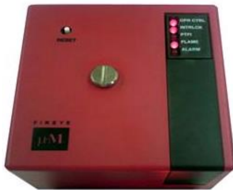
Figura 44. Controlador de Seguridad de FLAMA FIREYE
