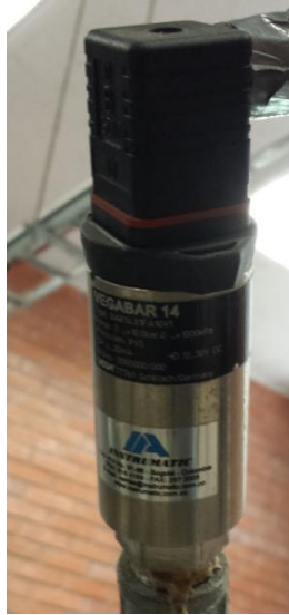
Figura 31. Sensor de Presión Vegabar 14 (PT)
