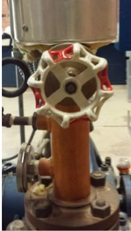
Figura 38. Válvula de compuerta
