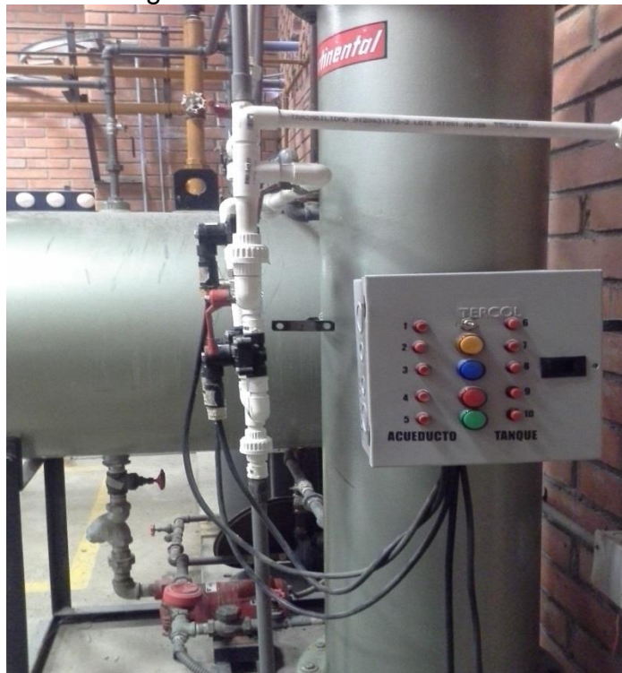
Figura11. Torre de enfriamiento
