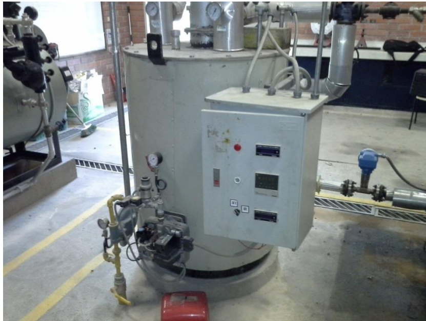
Figura 18. Sobrecalentador
