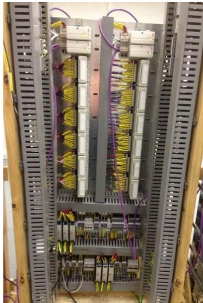
En la figura 43 se observan los módulos de entrada/salida y los módulos de comunicación con el procesador, los cuales son de un tamaño mucho menor, de una velocidad mayor y tecnología actual. En la parte inferior se encuentran las fuentes de alimentación, las cuales redujeron su tamaño drásticamente.
