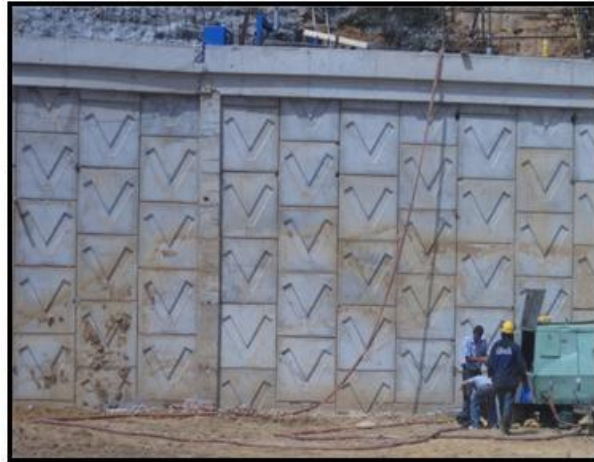
Figura 44. Vista del muro con viga
