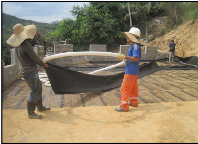
Figura 238. Preparación del filtro
