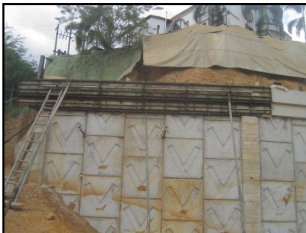
Figura 43. Encofrado para fundir viga
