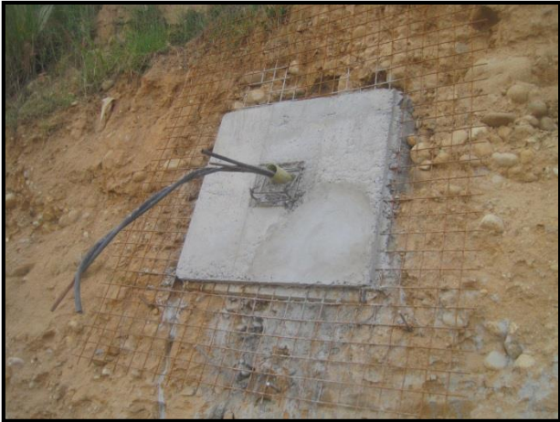
Figura 58. Pantalla de muro fundida
