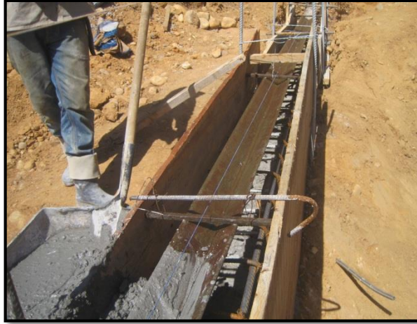
Figura 19. Formaletas para viga
