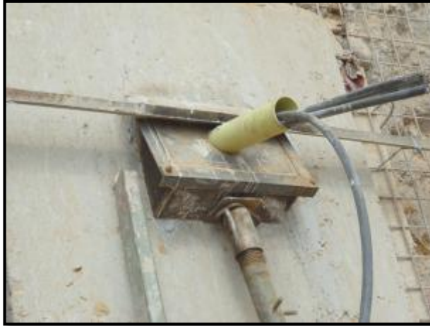
Figura 60. Fundida cabeza trapezoidal
