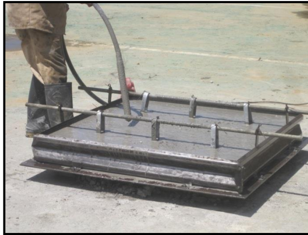
Figura 16. Vibrado para concreto
