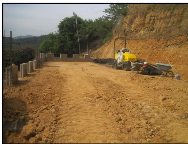
Figura 30. Compactación de relleno
