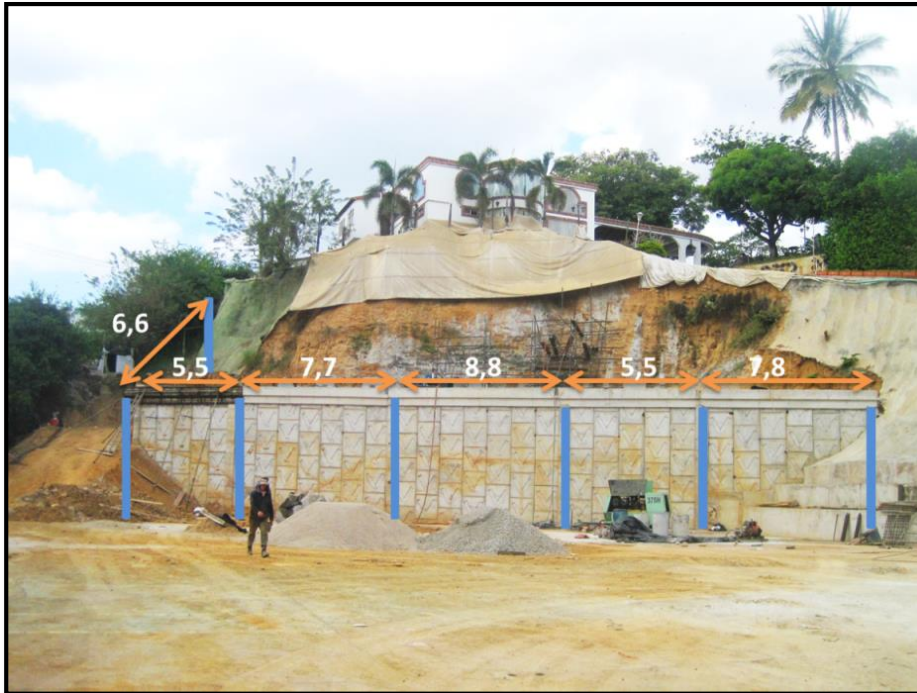
Figura 47. Muro en tierra armada terminado
