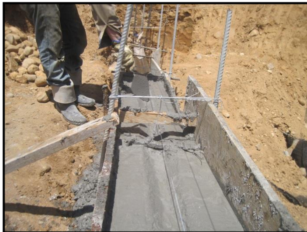
Figura 20. Fundida de viga
