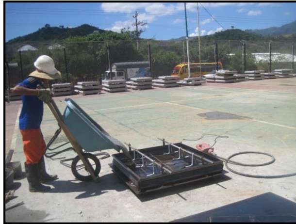
Figura 12. Vaciado de concreto
