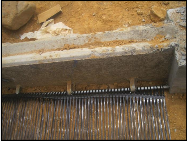
Figura 34. Unión de malla a las losas
