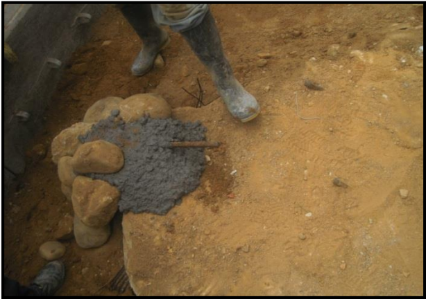
Figura 33. Bolo de concreto
