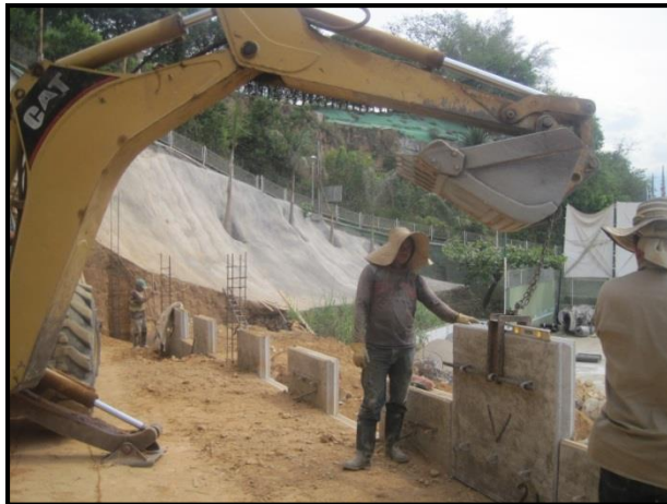
Figura 23. Instalación de losas
