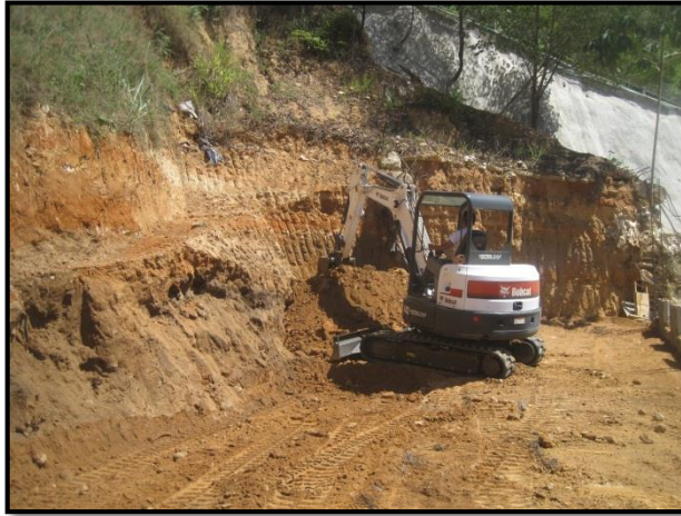
Figura 31. Perfilación del terreno
