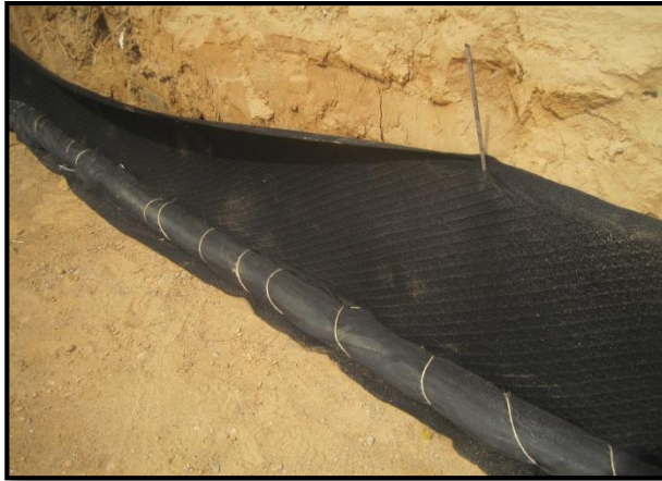
Figura 36. Filtro con Geosintético instalado en el pie del talud
