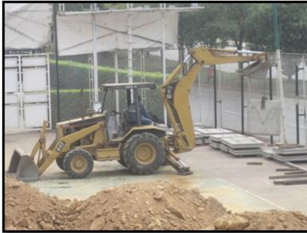
Figura 24. Transporte de losas
