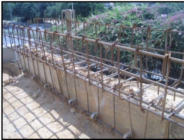
Figura 42. Amarre de aceros para viga
