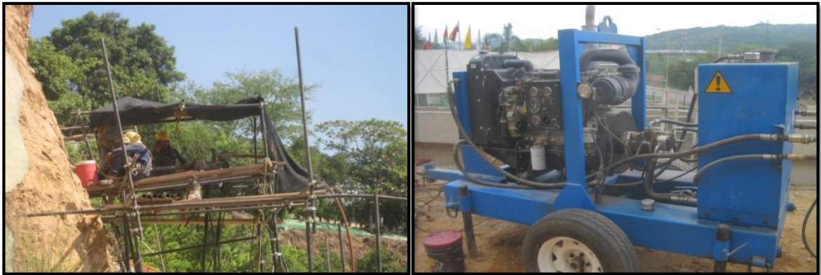
Figura 49. Sistema de perforación torque y Bomba de sistema hidráulico.
