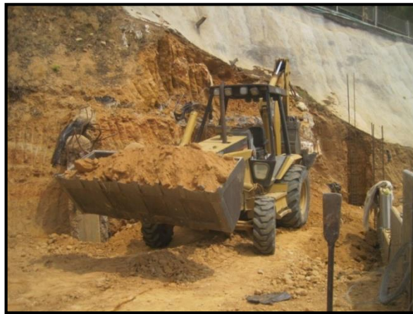
Figura 30. Compactación de relleno
