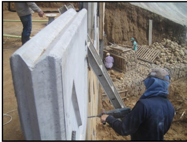
Figura 40. Perforación de losa
