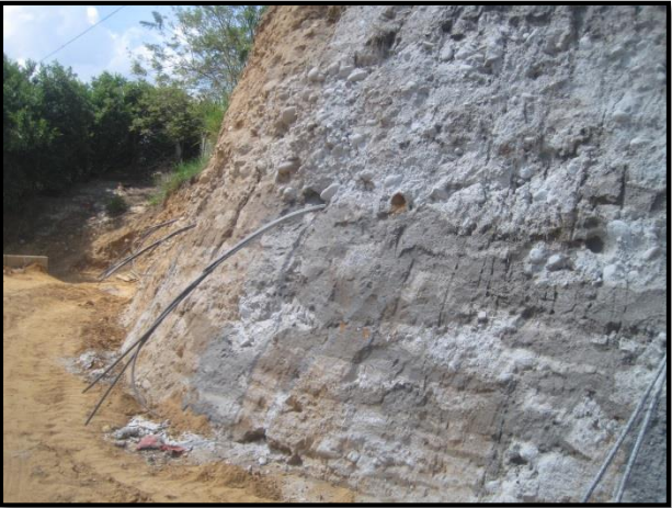
Figura 53. Tirantes instalados
