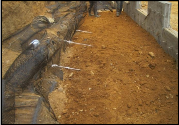
Figura 32. Guayas tensadas
