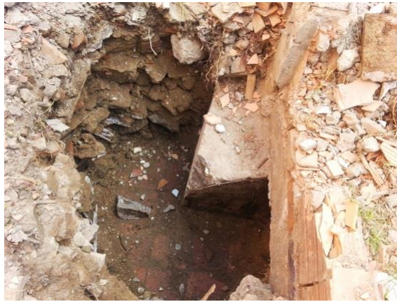
Fotografía 2. Demolición de placa para prehueco de pilotes
