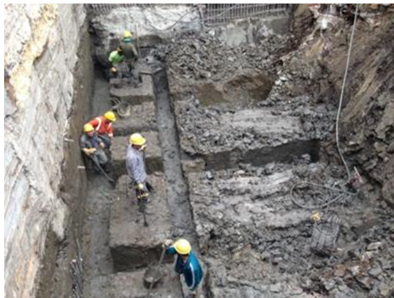
Fotografía 7. Excavación manual para cimentación
