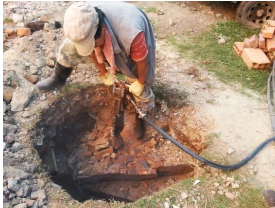
Fotografía 3. Demolición escalera sótano
