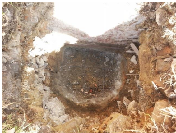
Fotografía 2. Demolición de placa para prehueco de pilotes
