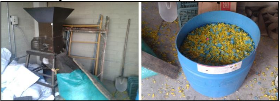
Figura 34. Cuarto de molienda de tapas plásticas.
