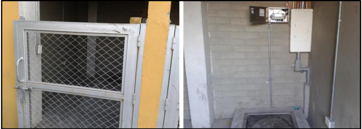
Figura 35. Cuarto de pesaje de materiales.
