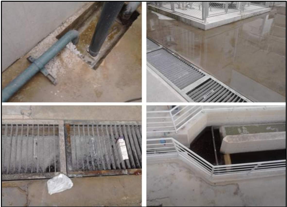
Figura 51. Descarga de soda recuperada.
