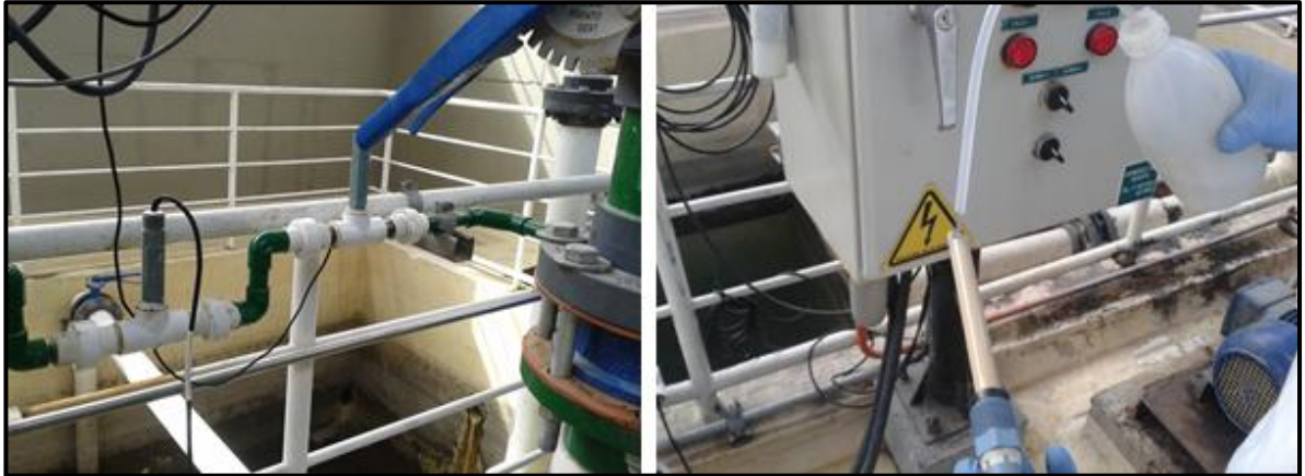
Figura 60. Revisión diaria de los sensores en el pre-tratamiento.
