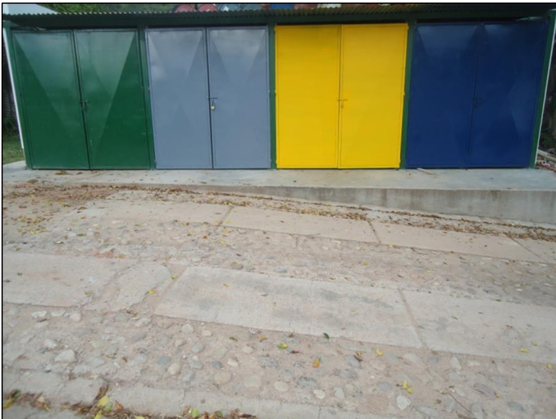
Figura 18 .Nuevo cuarto de almacenamiento de residuos.
