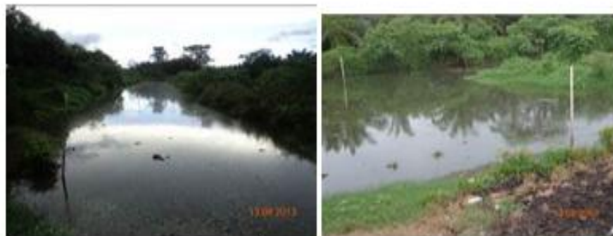
Inundación de los lechos de secado
