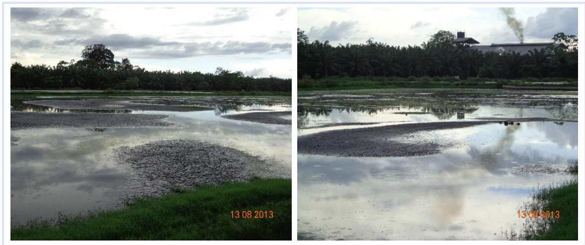
Figura 10. Colmatación en las lagunas anaerobias
