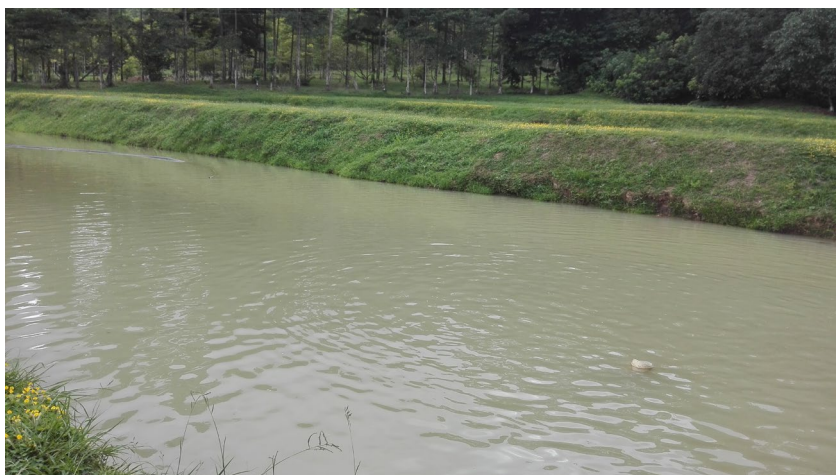
Foto 21. Estanques en tierra en el Carmen de Chucurí.
