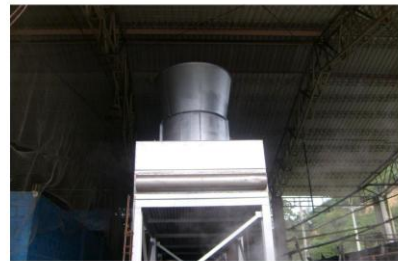
Nuevo aerocondensador
