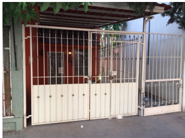
Figura 16. Reforzamiento de seguridad en viviendas.
