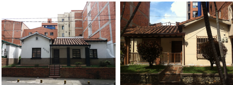
Figuras 19 y 20. Barrio Popular Modelo, construido por el Instituto de Crédito Territorial (1948).
