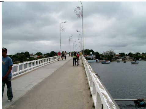
IMAGEN 50. Puente de acceso a la Isla de los Valadares.
