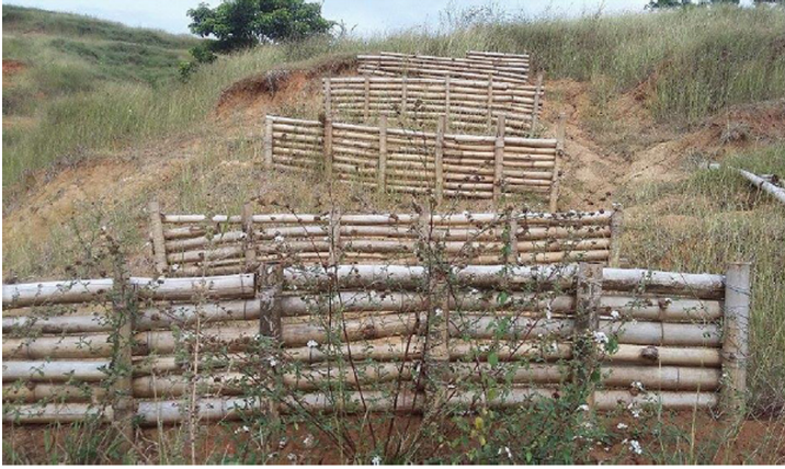
Figura 6. Área con trinchos
