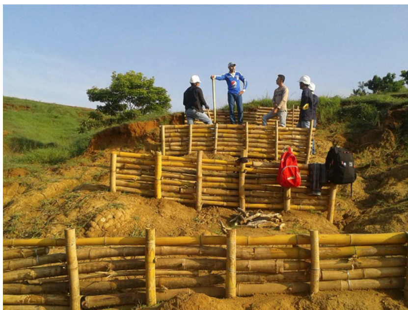
Figura 4. Estructura de trinchos
