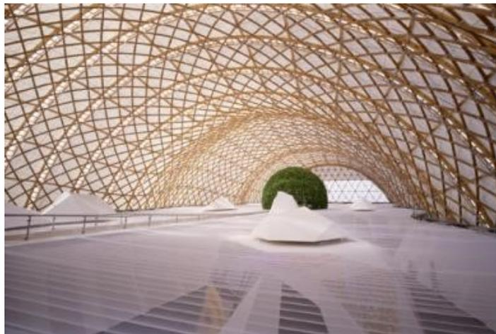
Figura 5. Estructura efímera a base de tubos de cartón diseñada por el arquitecto Shigeru Ban.
