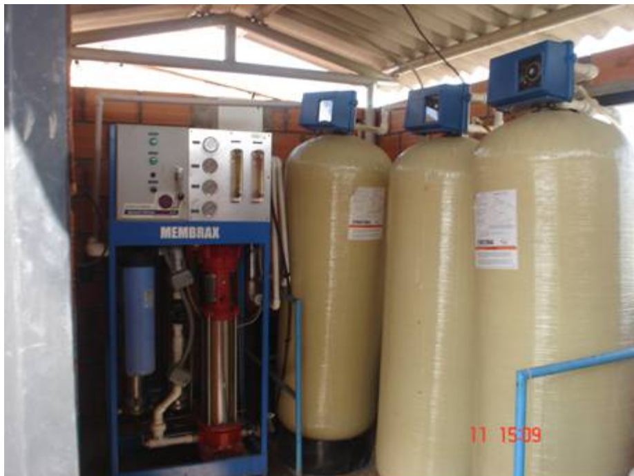
Figura 9. Vista planta de Osmosis Inversa
