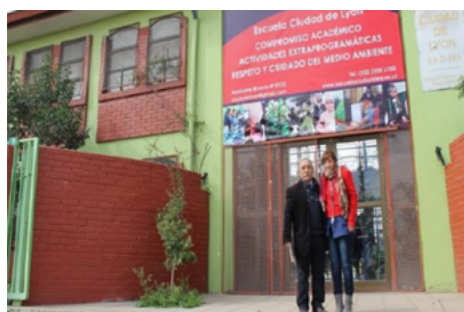
Figura 5. Fachada de la Escuela Ciudad de Lyon
