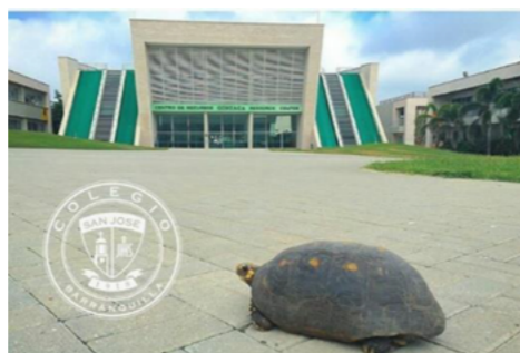
Figura 9. Fachada Colegio San José
