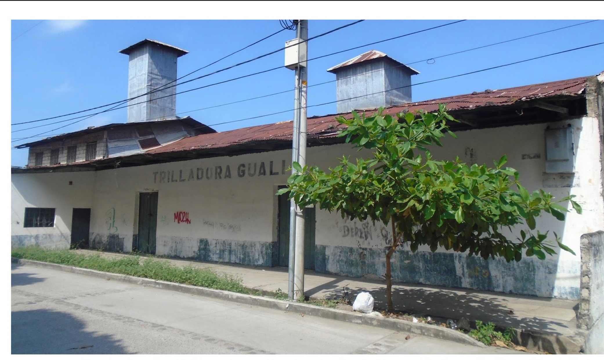
Situación Actual del Edificio - Acceso Exterior sobre la calle Ferrocarril - Fotografía: Tiberio Murcia Godoy
