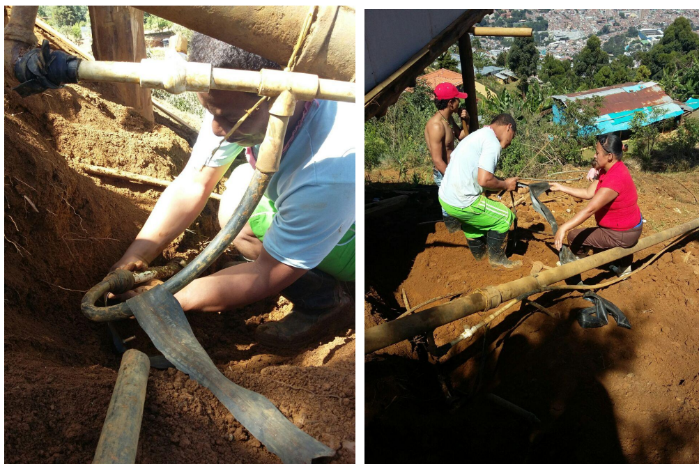
Tubería del alcantarillado comunal Tomado de: Registro fotográfico barrio El Faro
