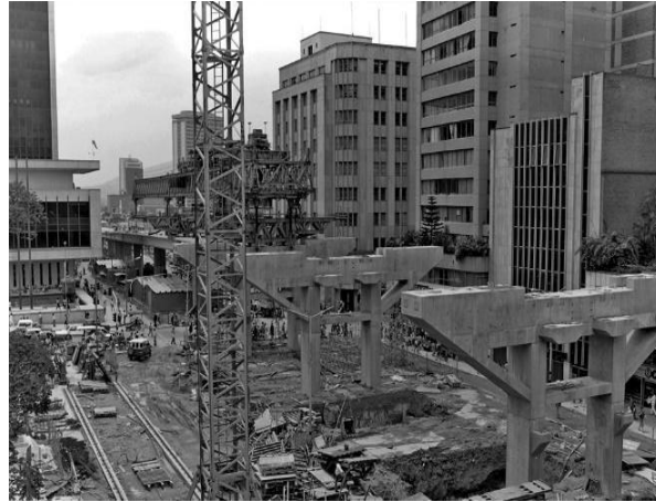
Ilustración 14: Construcción de la estación Parque Berrío del sistema Metro en los años 90.
