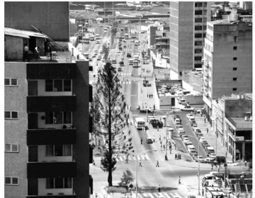
Avenida Oriental. Fotografía: Horacio Gil Ochoa. Archivo Fotográfico BPP.
