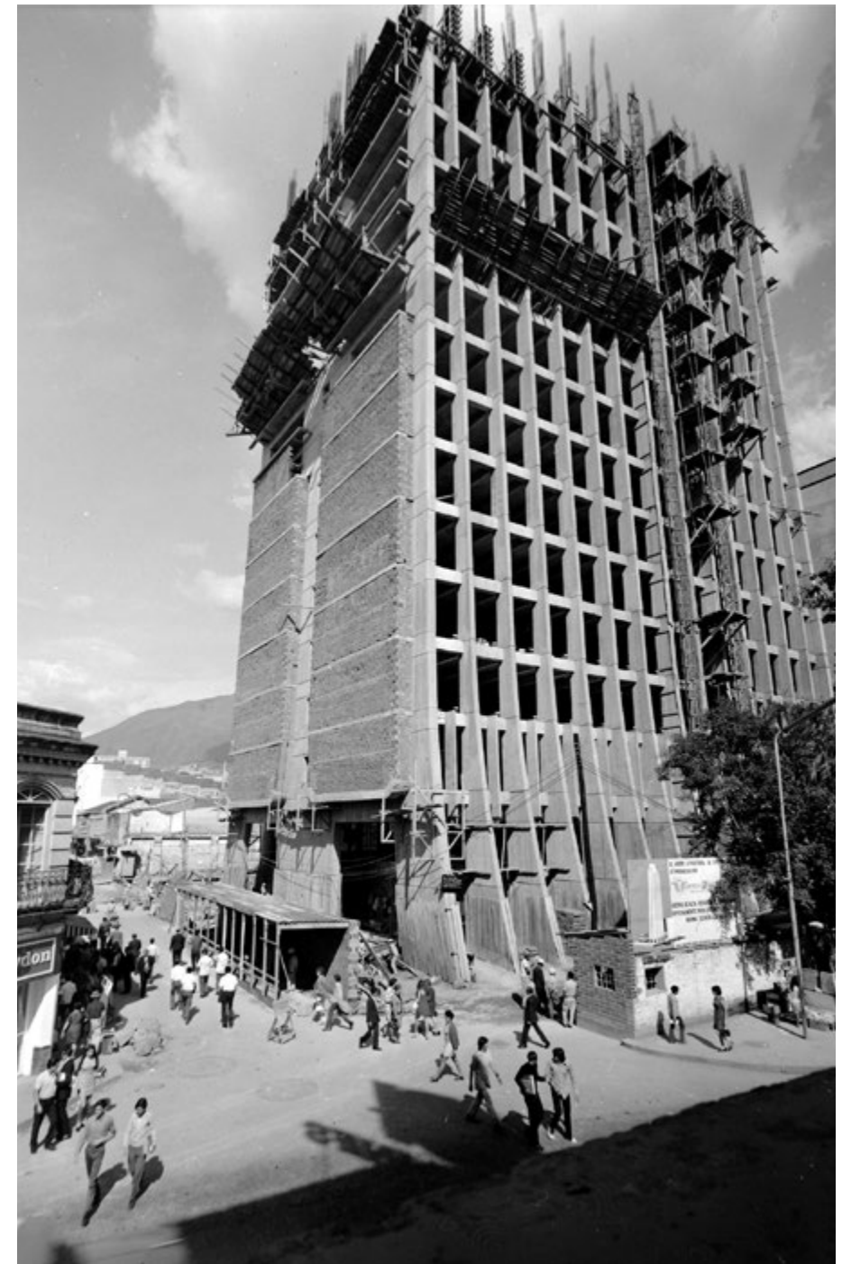
Edificio Coltejer en construcción. Fotografía: Gabriel Carvajal. Archivo Fotográfico BPP.
