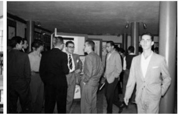
Muestra de trabajos en el nuevo edificio de la Facultad. Archivo Histórico UPB.
