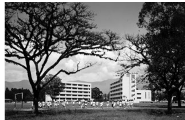
Construcción de la cruz de edificios de la UPB en el campo de Laureles. Fotografía: Gabriel Carvajal. Archivo Fotográfico BPP.
