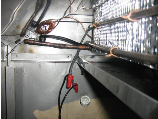
Figura 16. Resistencia eléctrica por aire forzado de 310 W en la Cámara de maduración.
