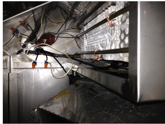
Figura 31. Resistencia eléctrica por aire forzado de 1500 W en la Cámara de Ambiente Controlado.
