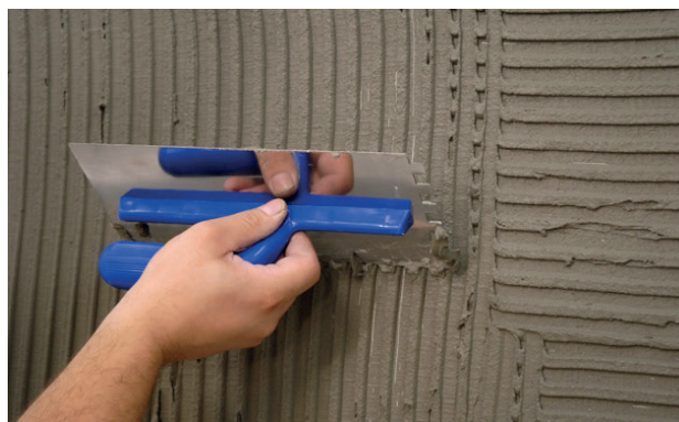
Figura 32. Textura sobre concreto fresco.
