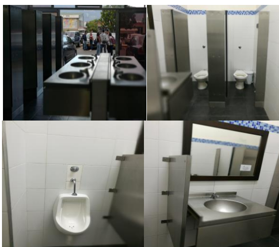
Figura 6. Baños Centro Tecnológico del Mobiliario
