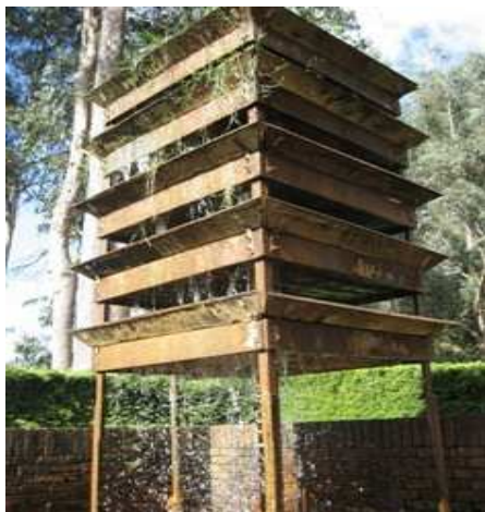
Foto 1: Estructura para la aireación del agua captada
