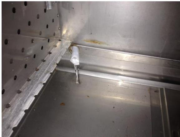
Figura 8. Llenado automático con válvula solenoide (parte superior Cámara de Maduración)
