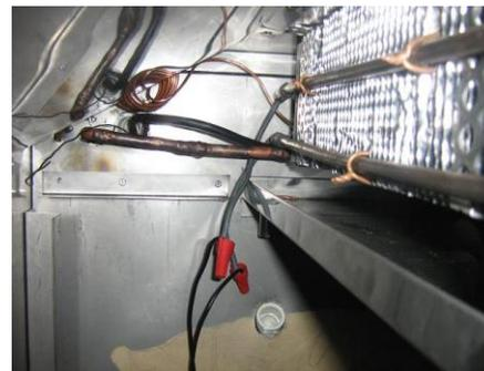
Figura 16. Resistencia eléctrica por aire forzado de 310 W en la Cámara de Maduración
