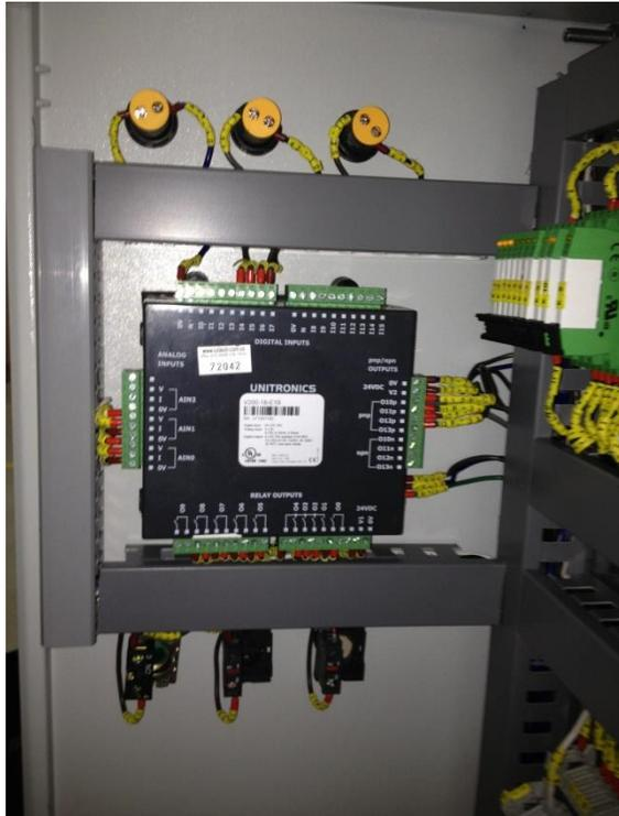
Figura 36. Gabinete cableado interno PLC
