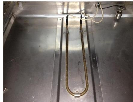
Figura 17. Humidificador por resistencia eléctrica sumergida de 1 kW
