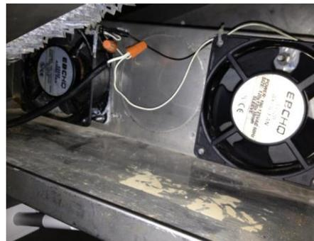
Figura 19. Ventiladores vista interna
