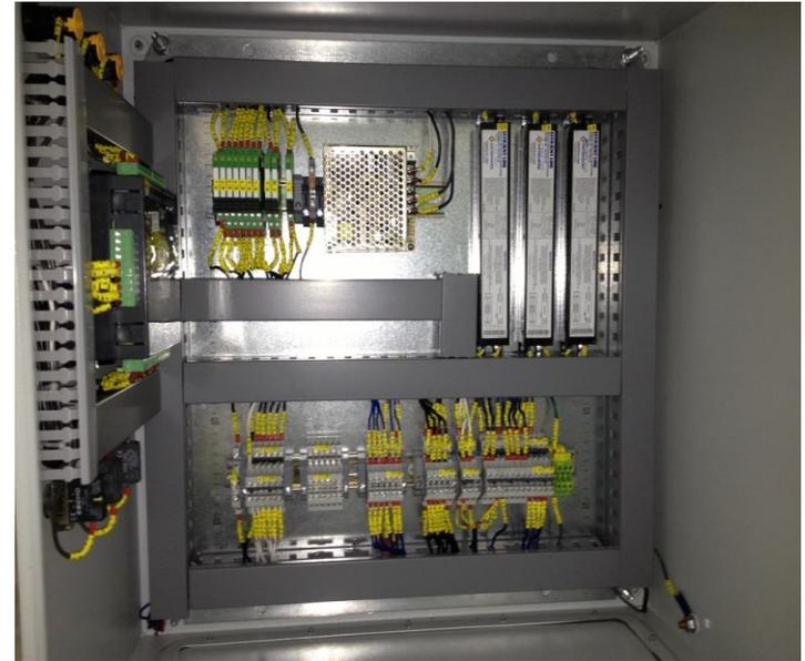
Figura 35. Gabinete cableado interno
