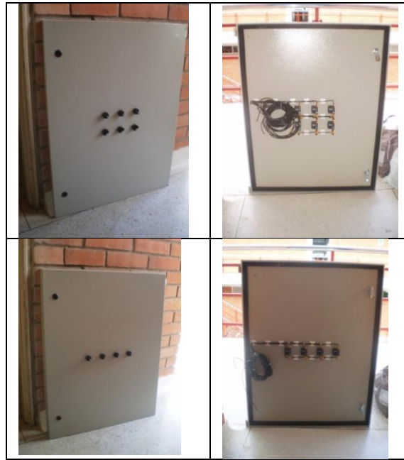
Figura 29. Instalación y conexión de los switches tipo perilla en las tapas de las celdas
