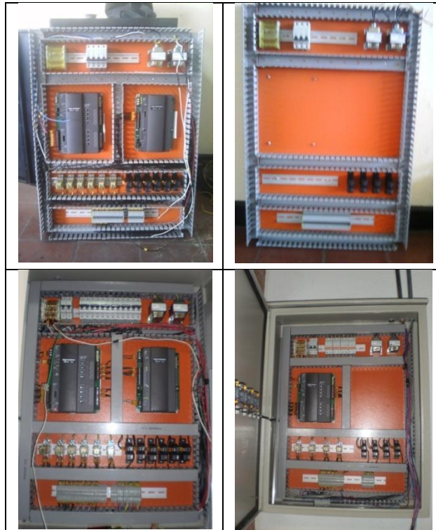
Figura 30. Instalación y cableado de los tableros de control.
