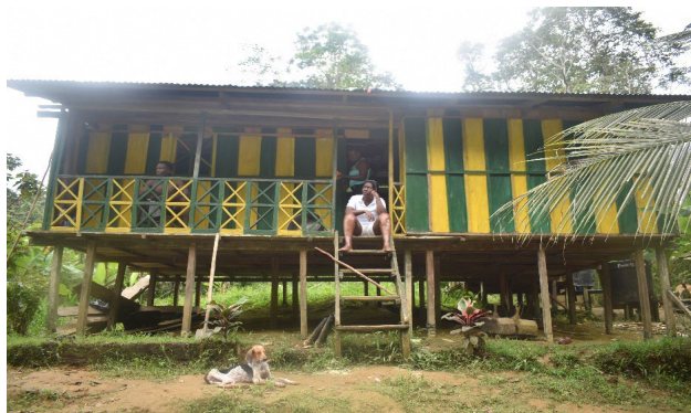
Figura 14 Casa en la ribera del río Mojaudó, corregimiento de Munguidó, Quibdó.
