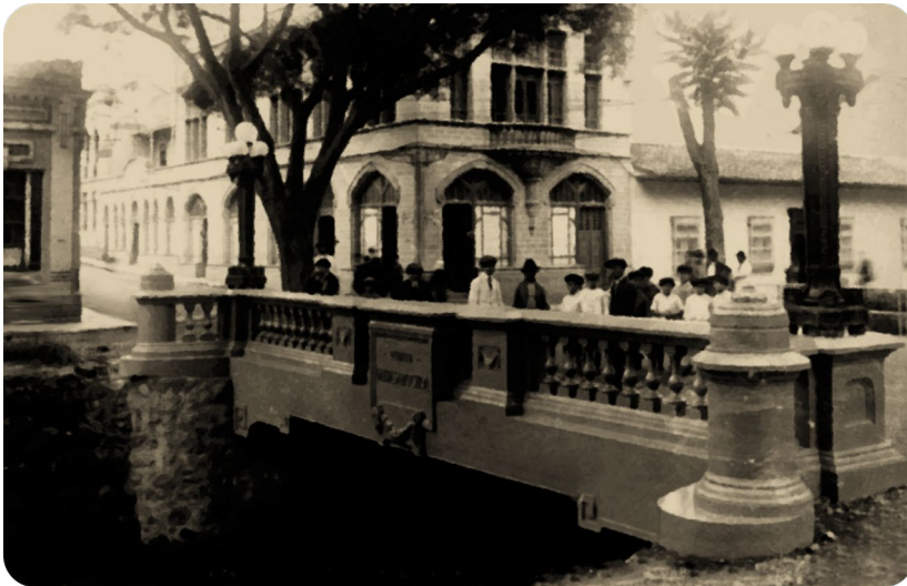
Figura 150 Lámpara de poste con cinco bombas en el puente Baltazar Ochoa, la Playa 1924
