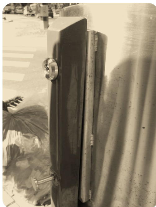
Figura 198 Sistema de eje y pasador fijador
