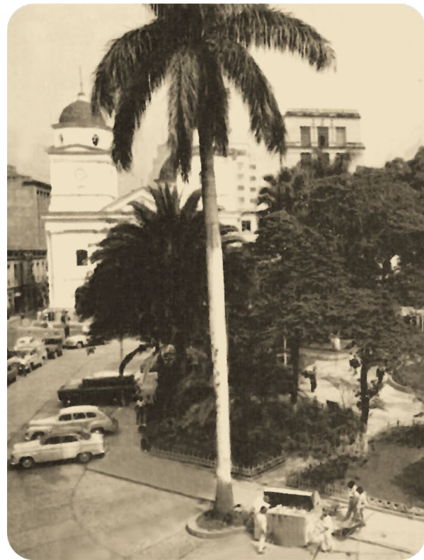
Figura 174 Caneca metálica de basura, 1950, vista de la esquina del costado noroccidental del Parque de Berrío
