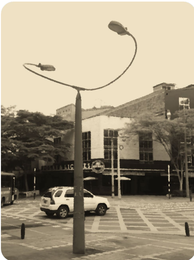
Figura 168 Lámpara tipo bailarina, de bombilla tubular de vapor de sodio de alta presión, con balasto
