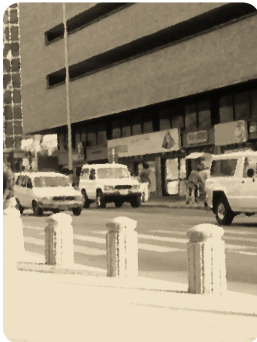
Figura 243 Bolardo en la avenida Oriental, 1993
