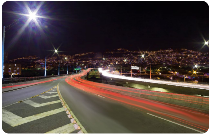
Figura 167 Lámparas LED amarillas de alto voltaje con control individual electrónico, 1998
