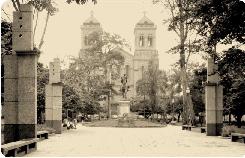
Figura 215 Bancas en concreto en el Parque de Bolívar 1940-1950
