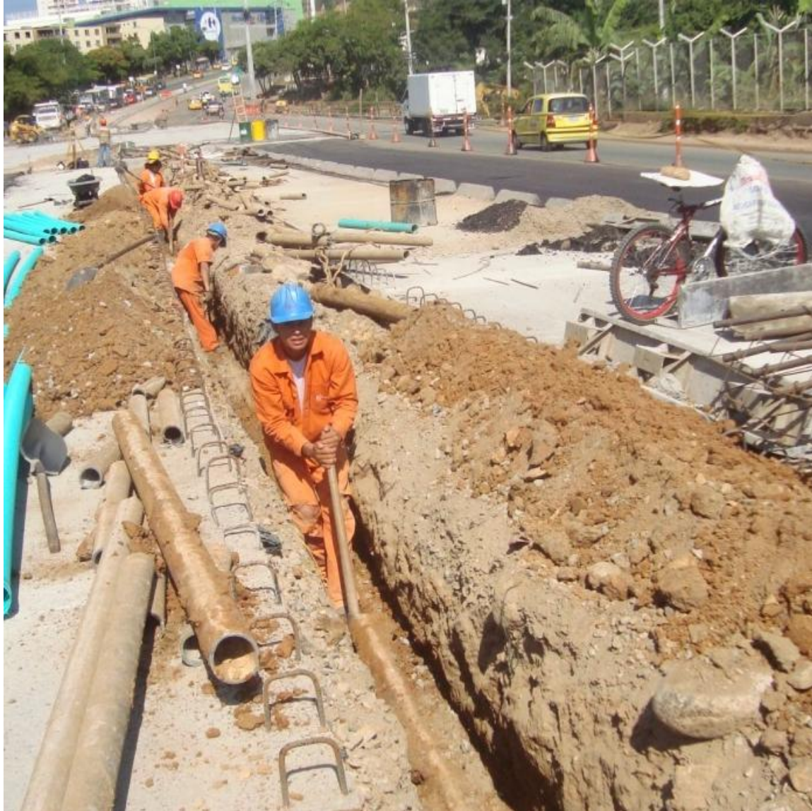
Fotografía #9. Canalización en el Separador Central, tramo 3 (Puente Cañaveral - PQP).
