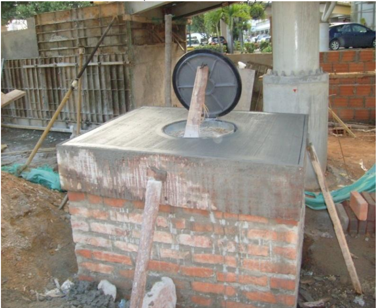
Fotografía #3. Mampostería para Cámara Nivelada bajo el Puente Peatonal de Cañaveral, tramo 3 (Puente de Cañaveral - PQP).
