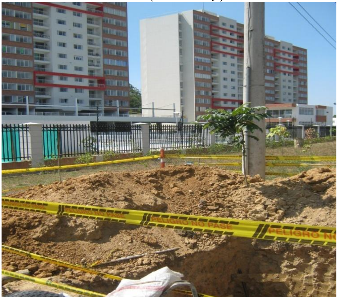
Fotografía #24. Señalización de cámara en construcción, Versalles Real -salida anillo vial- Tramo 3 (Cañaveral - PQP)
