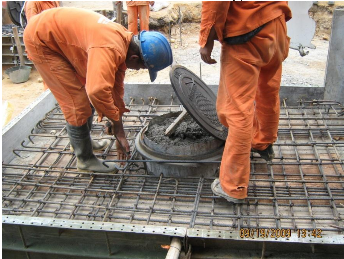
Fotografía #6. Amarre de hierro de refuerzo para losa superior de cámara tramo 3 (Puente de Cañaverál - PQP).
