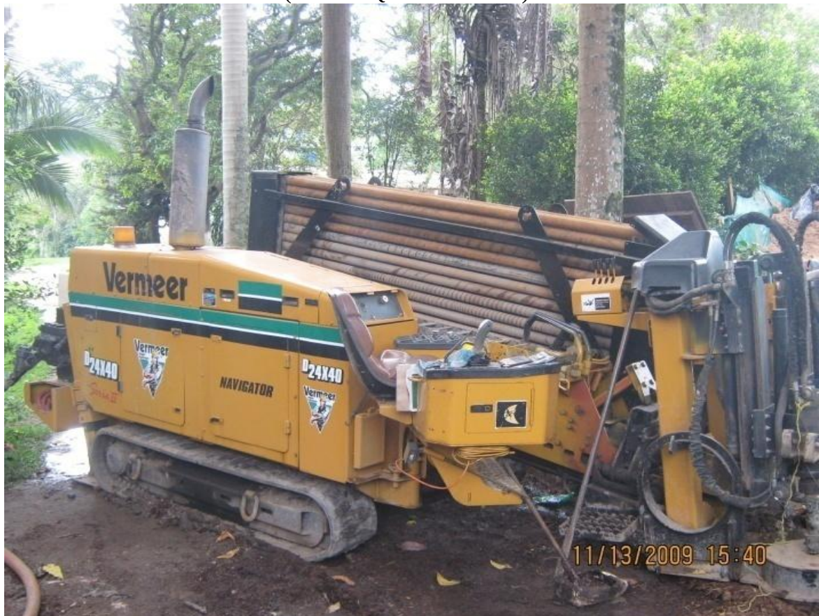
Fotografía #16. Equipo Topo Teledirigido, empleado para Cruces Transversales, (Tramo PQP - Piedecuesta).
