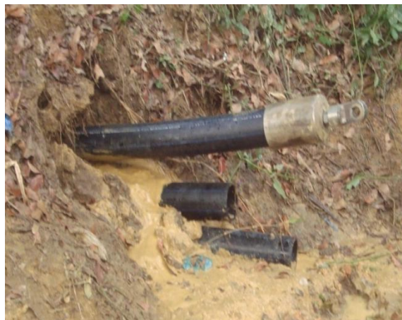
Fotografía #18. Ductos de Polietileno instalados en Cruce Transversal, PQP-Anillo vial
