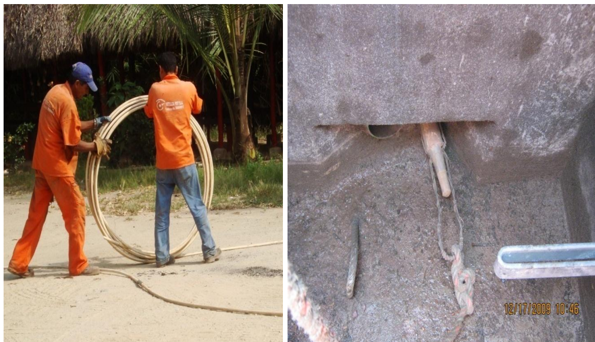
Fotografía #20. Sondeo de Ductos con patrón cilíndrico, (Tramo PQP - Piedecuesta)
