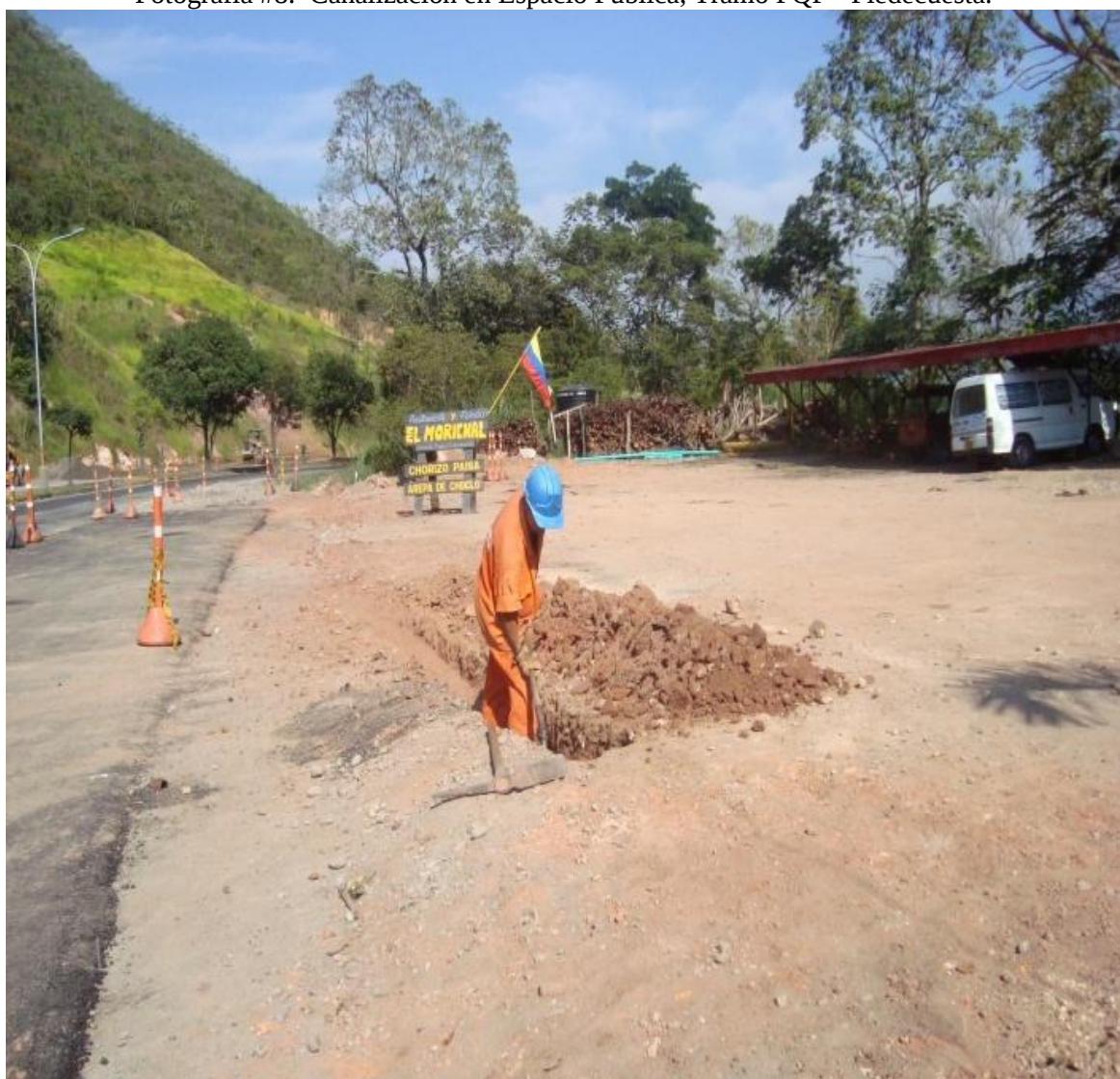
Fotografía #8. Canalización en Espacio Pública, Tramo PQP - Piedecuesta.
