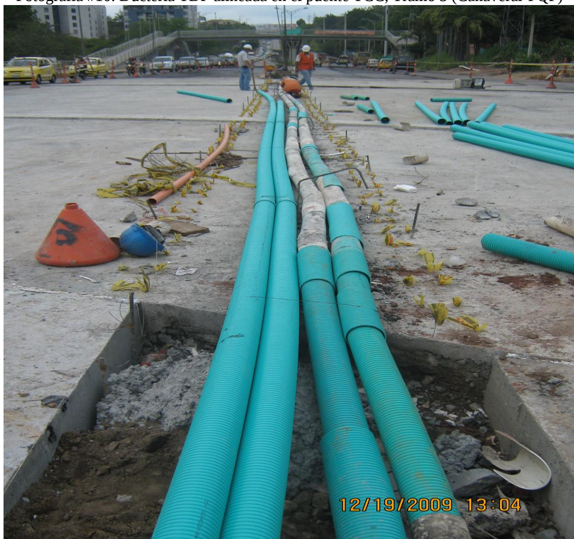
Fotografía #10. Ductería TDP alineada en el puente TCC, Tramo 3 (Cañaveral-PQP)
