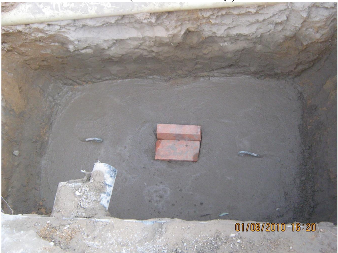
Fotografía #2. Ganchos de tiro embebidos en la placa de piso Versailles Real, tramo 3 (Puente de Cañaveral - PQP).
