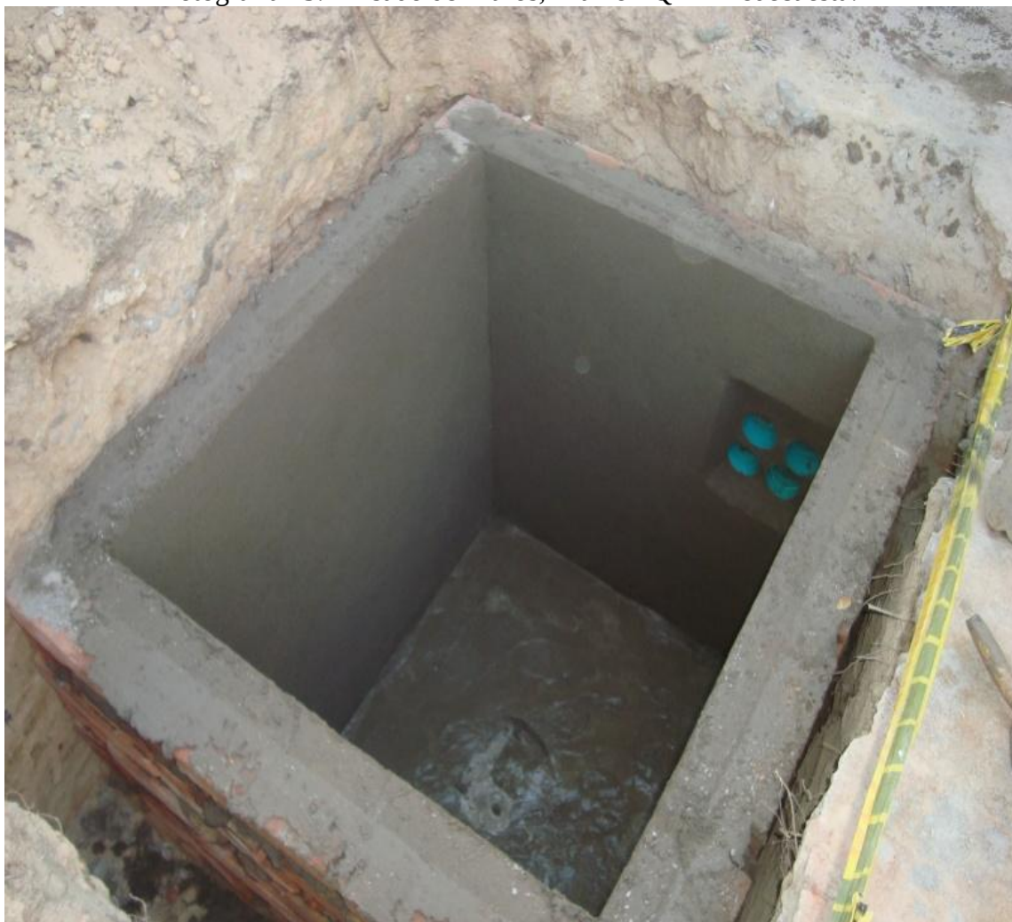
Fotografía #5. Frisado de Muros, Tramo PQP – Piedecuesta.
