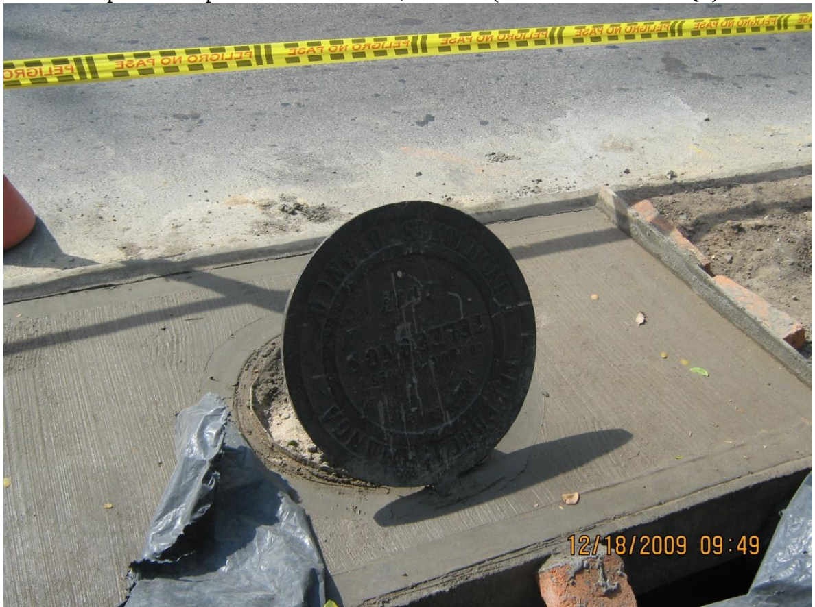
Fotografía #7. Aro-tapa en losa superior fundida de Cámara, Separador de puente vehicular TCC, Tramo 3 (Puente Cañaveral - PQP).
