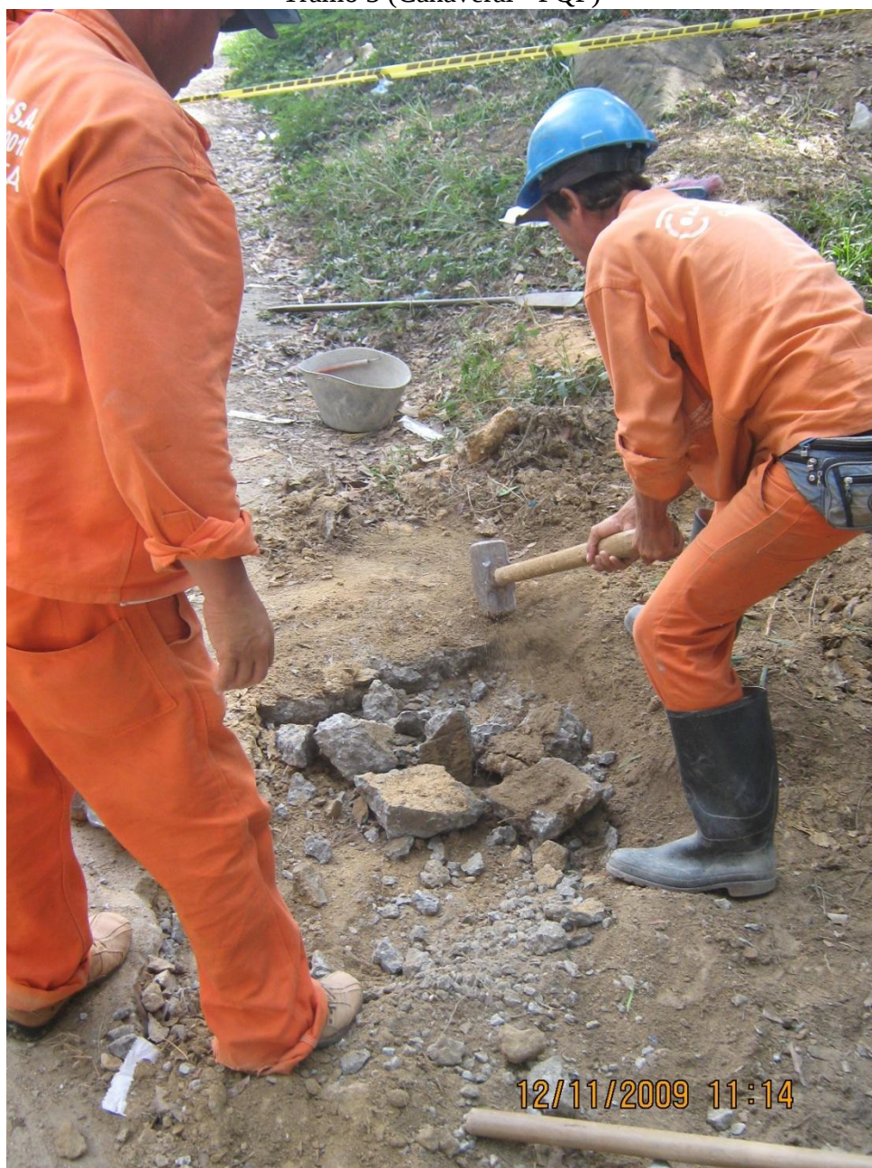
Fotografía #22. Demolición manual de andén, Versalles Real -salida anillo vial Girón- Tramo 3 (Cañaveral - PQP)
