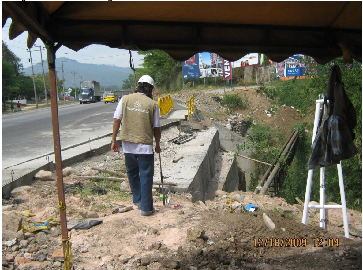
Fotografía #19. Cruce Longitudinal con Cercha Metálica, Puente San Carlos -Piedecuesta-
