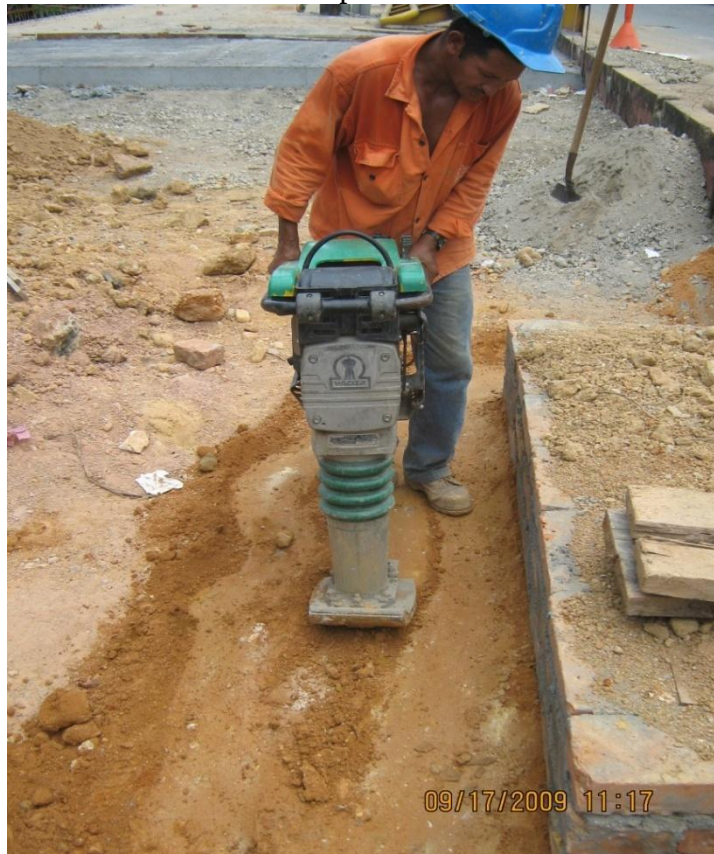
Fotografía #14. Relleno lateral compactado de cámaras Cañaveral, tramo 3
