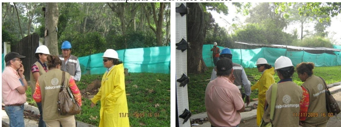
Fotografía #32. Recorridos de Obra para verificar el Inicio de Trabajos por parte de las Empresas de Servicios Públicos
