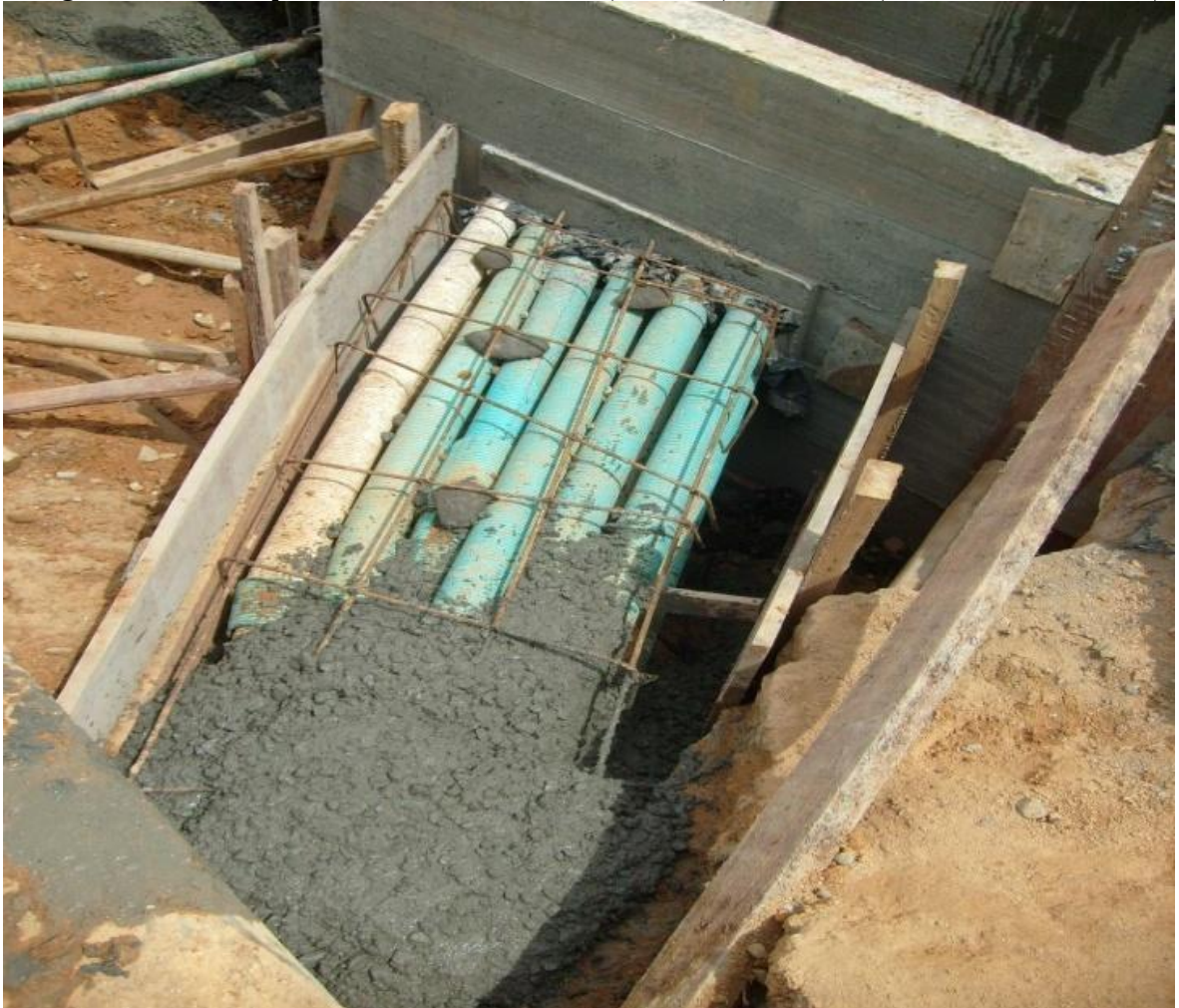
Fotografía #15. Atraque en concreto reforzado (cárcamo), Tramo 3 (Pte Cañaveral – PQP).
