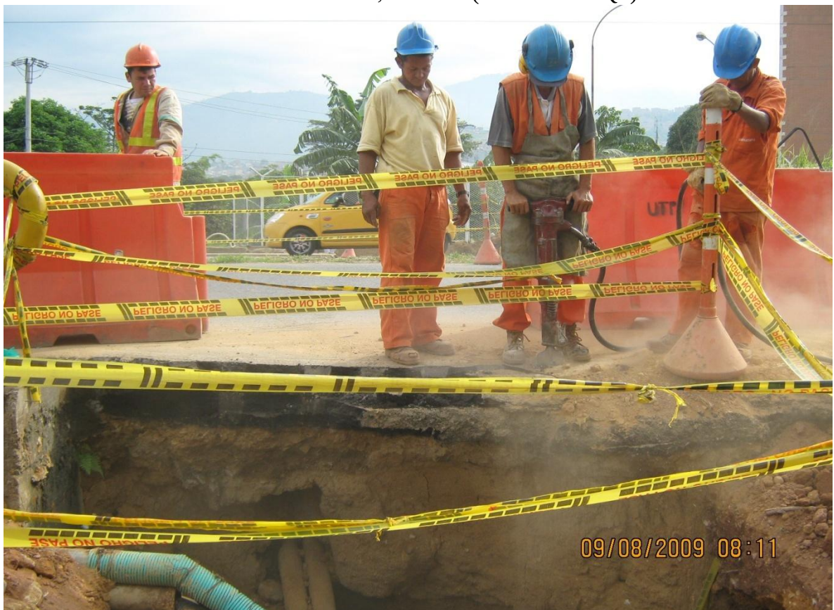
Fotografía #21. Señalización para demolición mecánica de pavimento, Puente de Cañaveral, Tramo 3 (Cañaveral - PQP)
