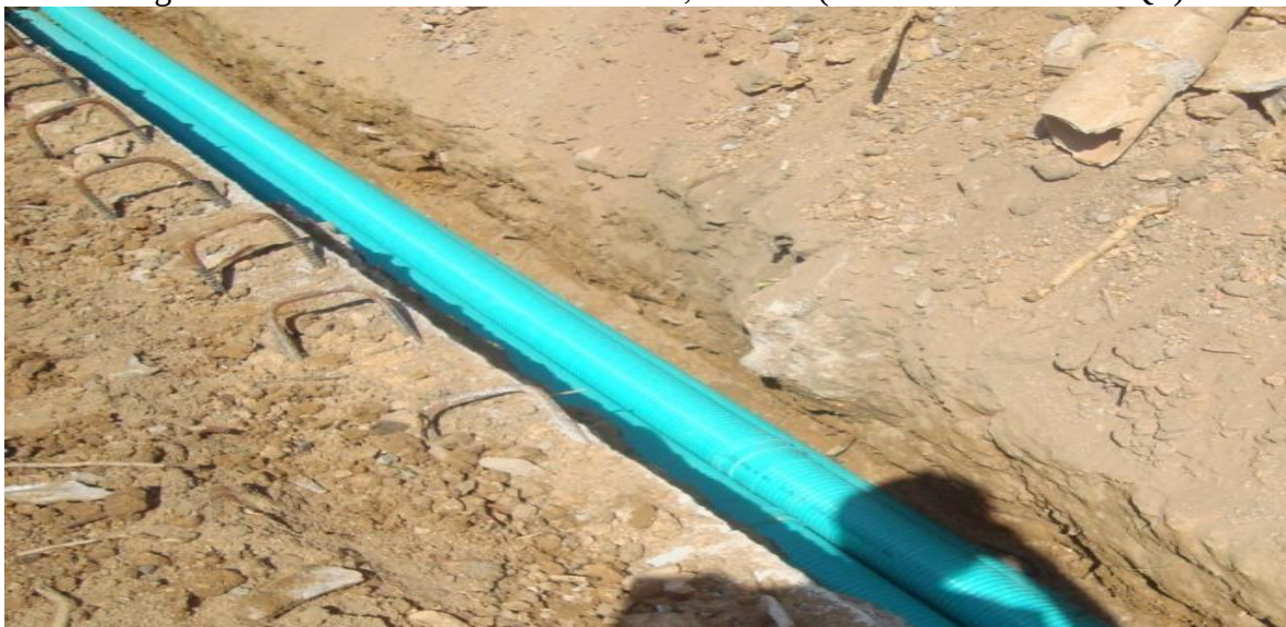
Fotografía #12. Instalación de ductos TDP, tramo 3 (Puente Cañaveral – PQP).
