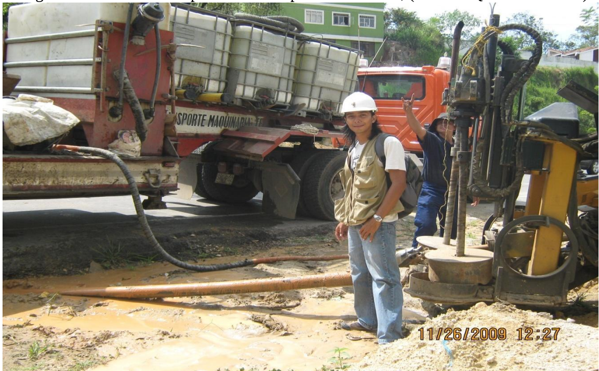
Fotografía #17. Perforación para Cruces Topo Transversales, (Tramo PQP - Piedecuesta).
