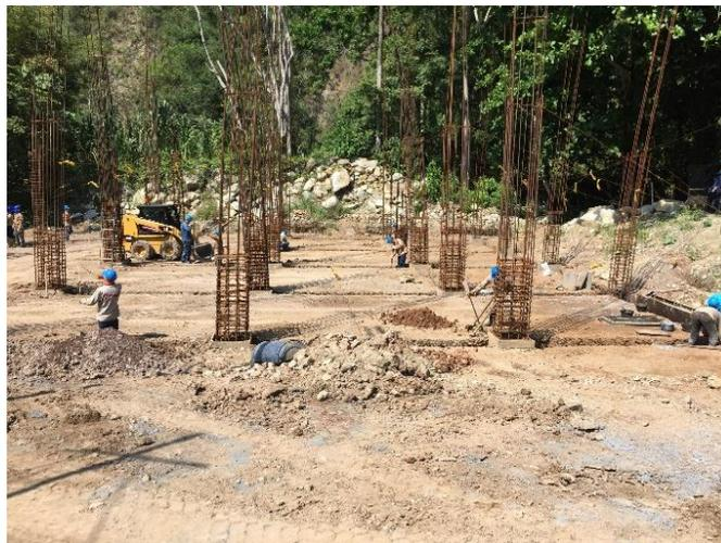
Figura 41 Excavación para las vigas de cimentación. Fuente: Propia
