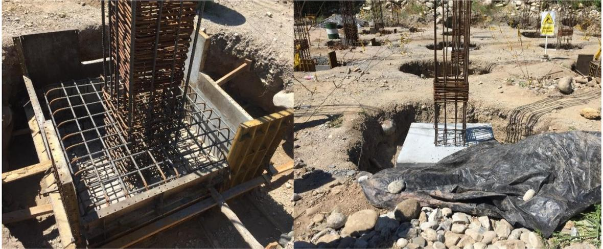
Figura 40 Construcción zapatas de cimentación. Fuente: Propia
