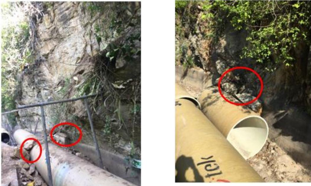
Figura 15 Tubería afectada por desprendimiento de rocas. Fuente: Propia
