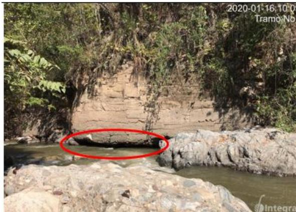
Figura 16 Socavación. Fuente: Consorcio Integral
