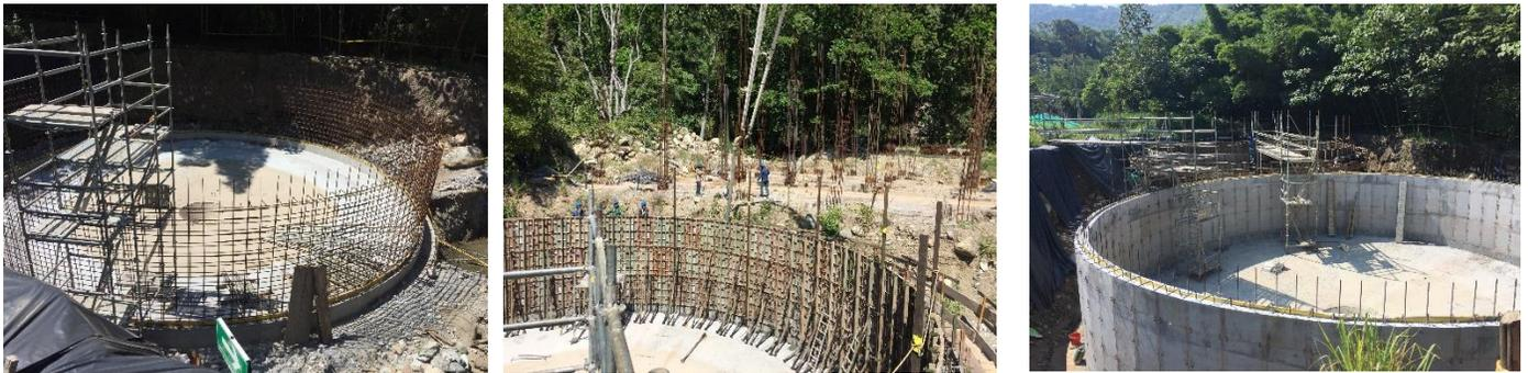
Figura 39 Proceso constructivo de muro espesador. Fuente: Propia
