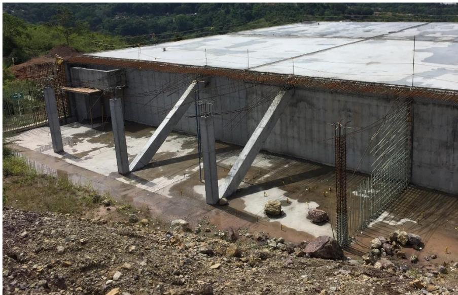
Figura 33 Columnas sin finalizar su proceso de fundición.
