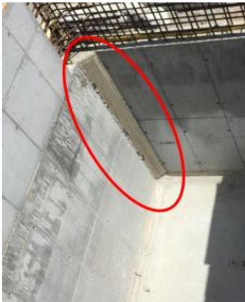
Figura 34 Hormigueo en juntas entre placas. Fuente: Propia
