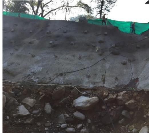
Figura 12 Proceso de estabilización talud. Fuente: Propia
