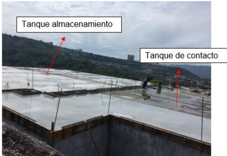
Figura 32 Tanque de contacto y tanque de almacenamiento. Fuente: Propia
