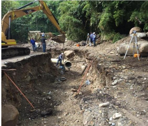
Figura 9 Ubicación e instalación de la tubería GRP. Fuente: Propia- Acueducto Metropolitano de Bucaramanga S.A E.S.P.
