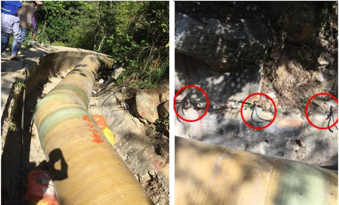
Figura 14 Pernos para la construcción del atraque a la tubería. Fuente: Propia
