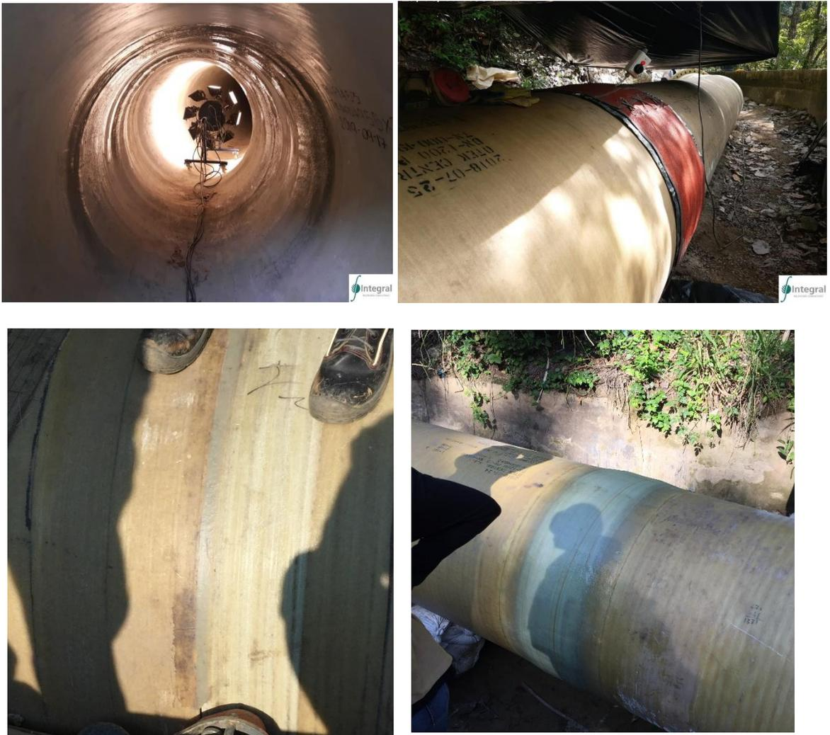
Figura 13 Proceso de elaboración de juntas laminadas en la tubería GRP. Fuente: Propia
