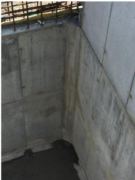
Figura 35 Corrección juntas entre placas. Fuente: Propia
