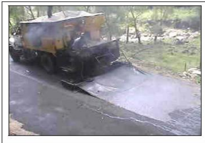
Ilustración 6 Imprimación y lechada asfáltica
