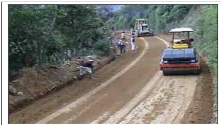
Ilustración 5 Compactación de Material estabilizado
