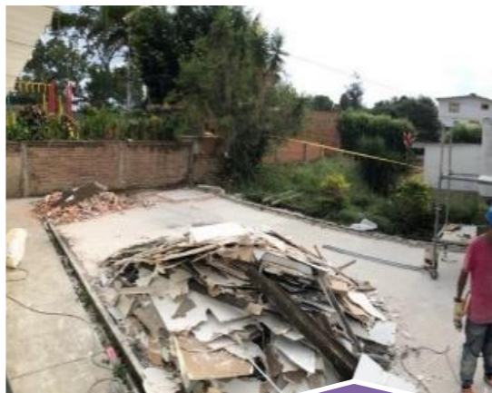
Demoliciones de pisos en concreto entre (10 a 15 cm): Se realizaron las demoliciones de los pisos de un CAI existente y una casa de Bienestar Familiar.
