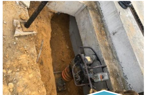
Relleno con recebo Tipo B-200 COMPACTADO AL 95% DEL PROCTOR MODIFICADO, ESPESOR 0.20 M: Para los sobre anchos que se debieron hacer para los muros de tanque de almacenamiento de agua, y algunas excavaciones de zapatas se utilizó recebo tipo B200.
