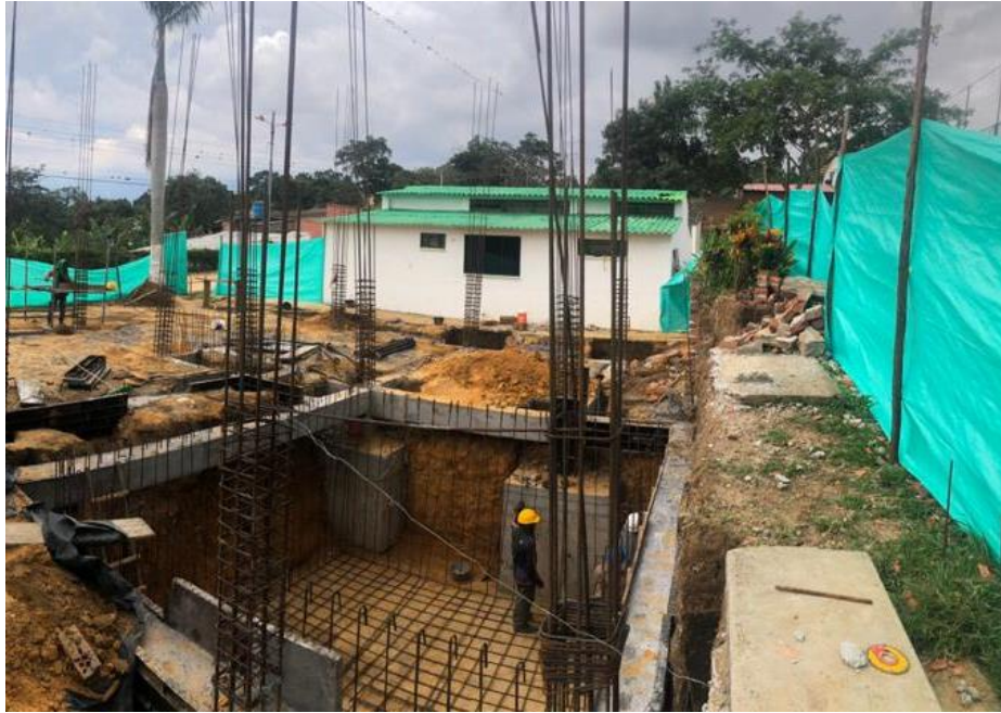
Imagen 8. Registro fotográfico de cimentación junto a tanque de almacenamiento.
