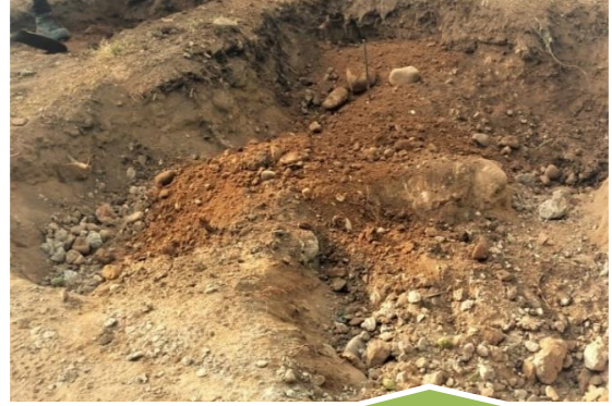
Excavación en roca: En esta imagen se evidencia que al excavar se encontró en el suelo roca, el cual se manejó con un porcentaje del 20% de la excavación en material común.
