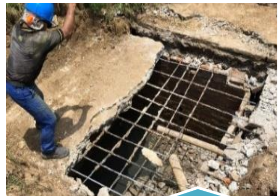
Demolición de estructuras en concreto reforzado: La anterior imagen fue la demolición de una tapa de un pozo septico que ya no se encontraba en funcionamiento, pero además de esto se hicieron demoliciones de columnas y vigas que hacían parte de la estructura del CAI existente.
