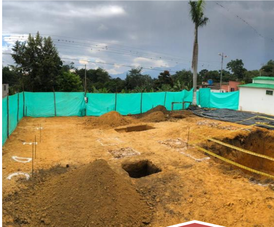
Cerramiento provisional en tela verde: Esta actividad se realizó para que todo el area a construir quedara aislada.
