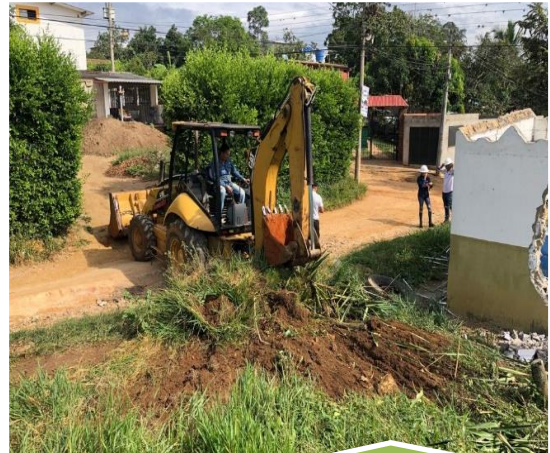
Desmonte y descapote: Se debió realizar para una limpieza cuyo fin fue eliminar la vegetación existente sobre el terreno a construir.
