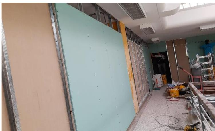
*Ilustración 13 construcción de muro en Drywall*
