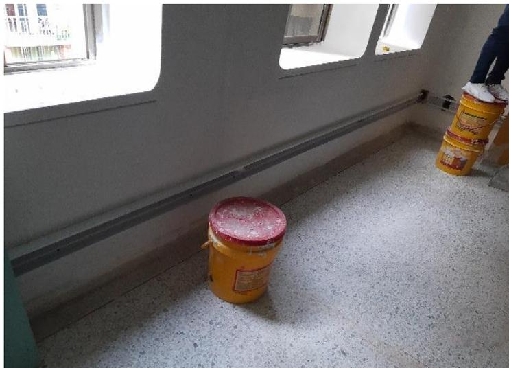
*Ilustración 8 Instalación de canaleta*
