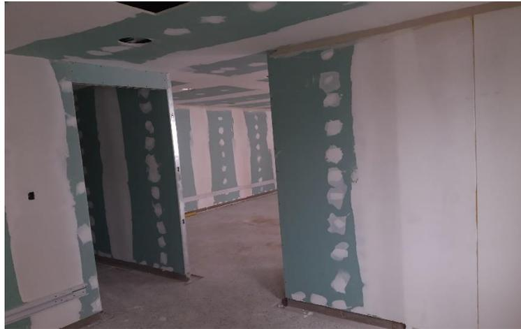
*Ilustración 22 Empastado de Muros*
