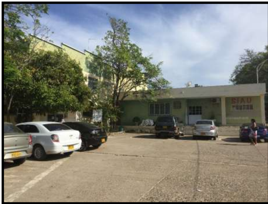
2. Vista exterior de los bloques del área administrativa y financiera
