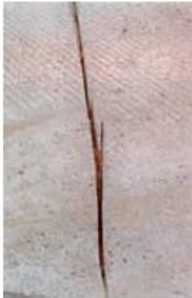
figura 12. Desviaciones en el corte de la junta.
