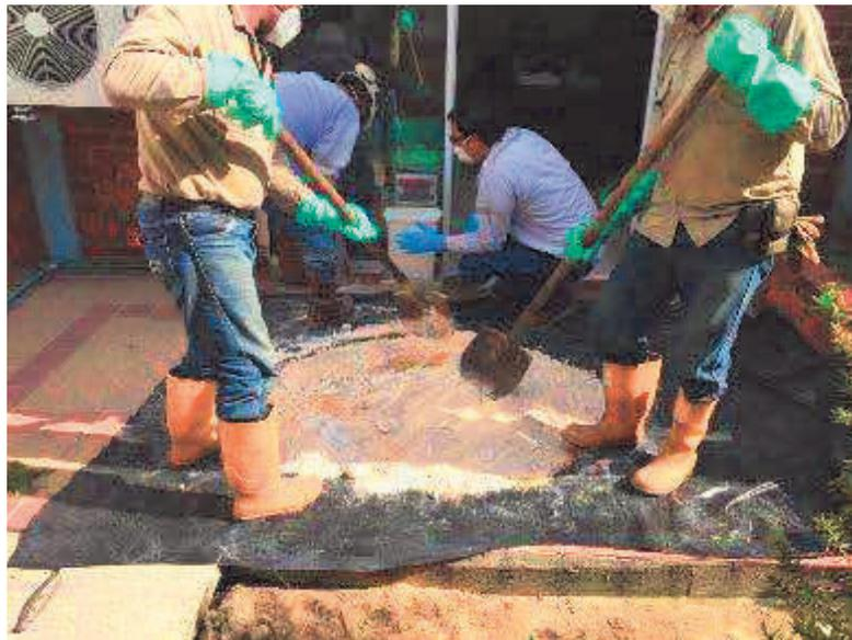
*Ilustración 7.* Volteo manual para la mezcla de material de afirmado, sedimentos con hidrocarburos y cal hidratada
