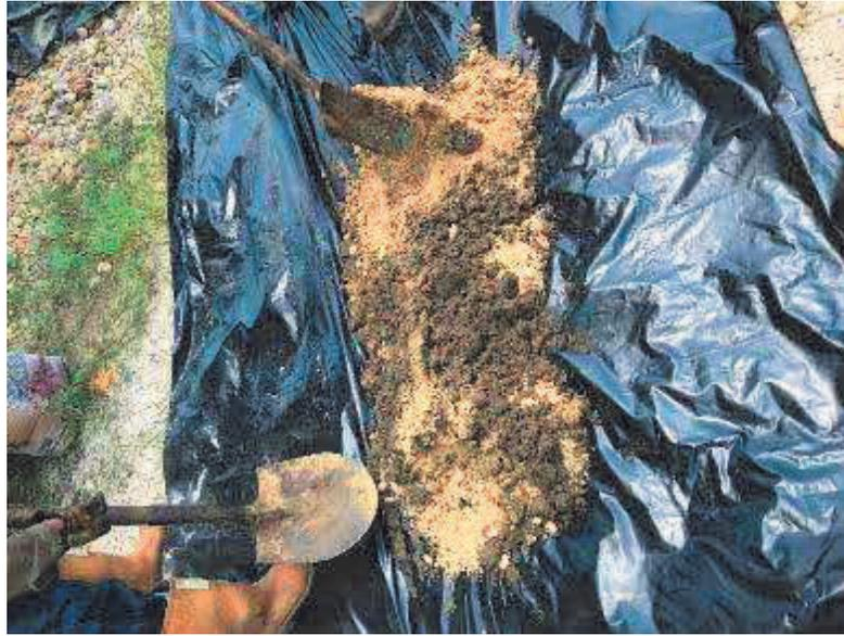
*Ilustración 6.* Mezcla de material de afirmado, sedimentos con hidrocarburos y cal hidratada
