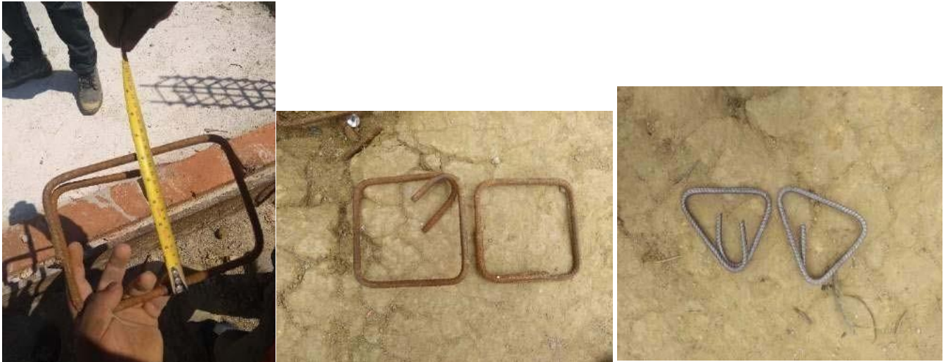
Figura 43-Diferencia de estribos que cumplen la norma
