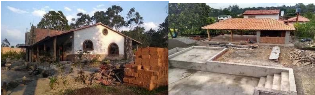
Figura 19-Inicios de obra Altamira 2
