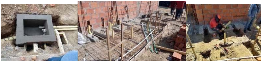
Figura 44-Sistemas hidrosanitarios en obras de Construmesa S.A.S.
