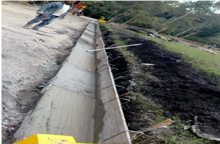
Figura 35- Canaletas en concreto
