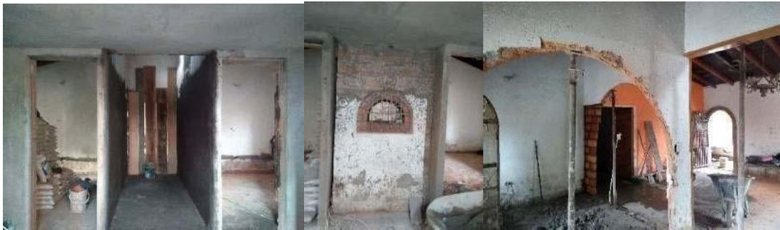
Figura 20- Interior de construcción
