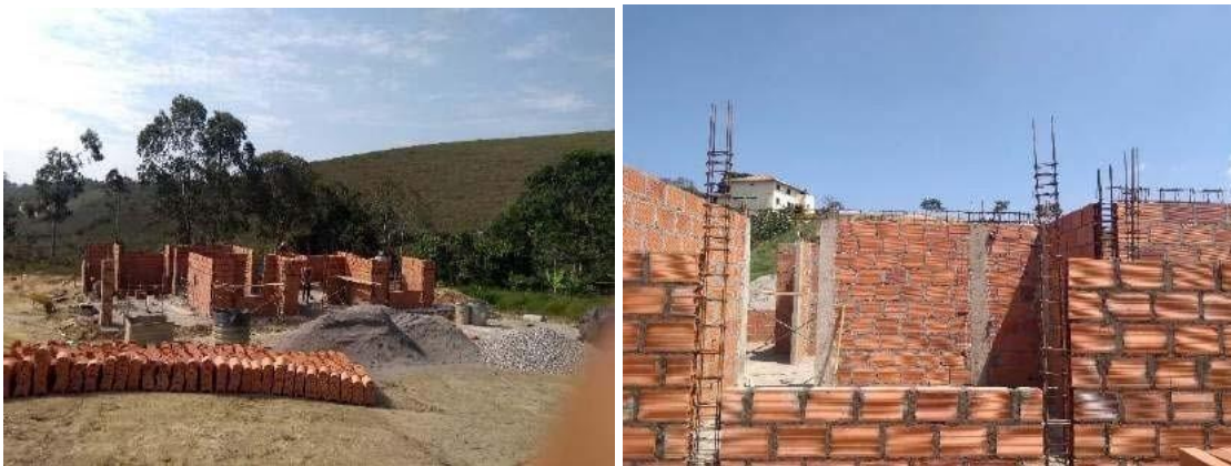
Figura 26- Inicio Obra las Margaritas
