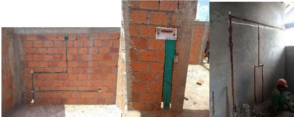
Figura 29-Regatas o Aberturas para instalación de tuberías
