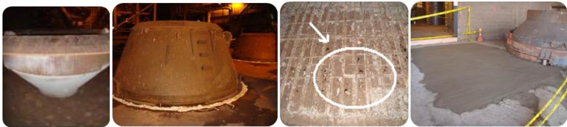
Fig. 41. Reparación grouting de las tolvas de alimentación y reparación piso de concreto. Fuente: Autor
