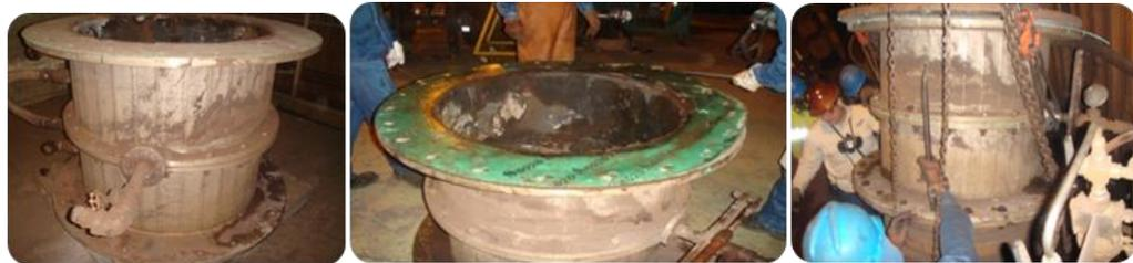
Fig. 42. Cambio de anillos del dämper. Piso de carga. Fuente: Autor
