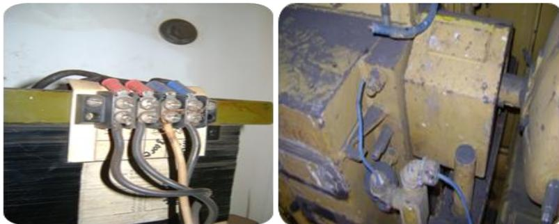
**Fig. 50. Fallas en el cableado. Fuente: Autor**
