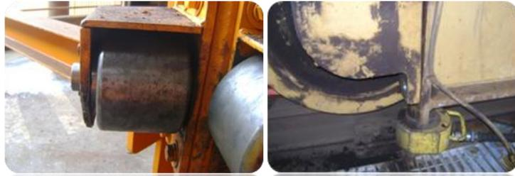
**Fig. 48. Cambio de rodillos y ruedas de la grúa. Fuente: Autor**
