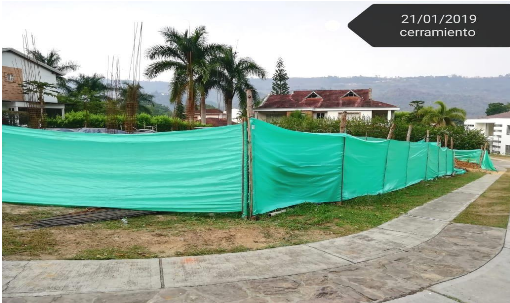
Fotografía 1. Cerramiento de obra con poli sombra
