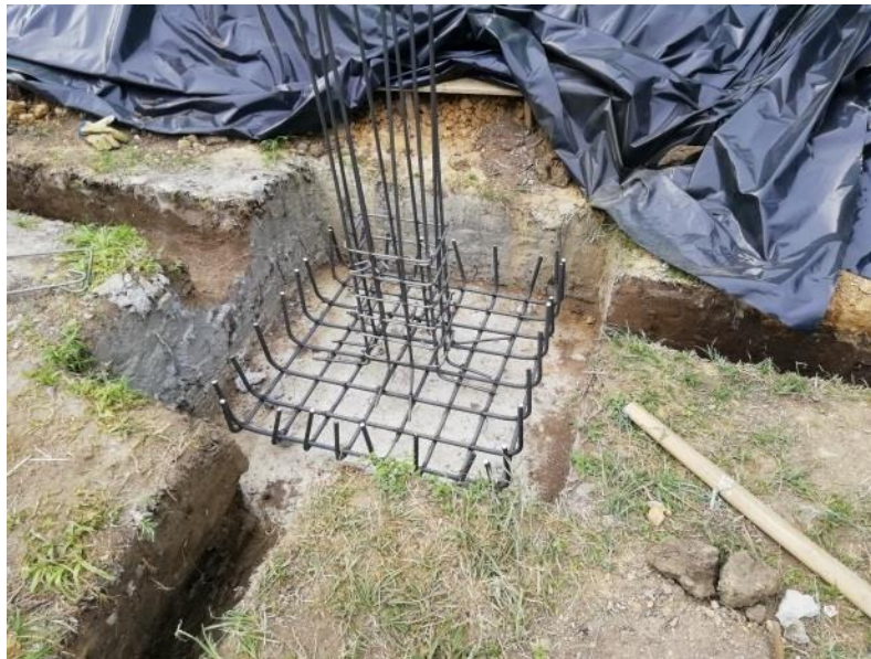
Fotografía 11. Refuerzos de base de columna
