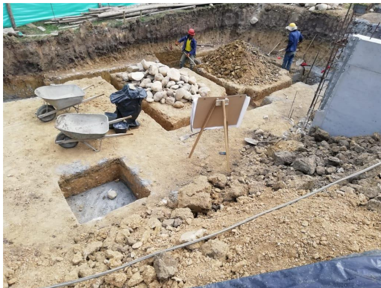
Fotografía 26. Semisótano con excavaciones de zapatas y vigas de amarre
