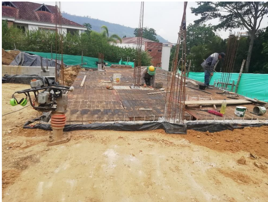
Fotografía 30. formaleta de placa semisótano
