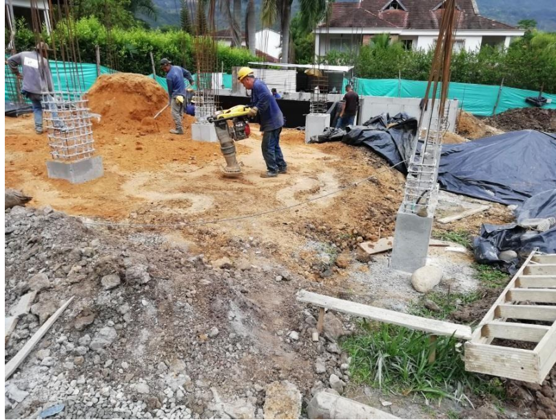
Fotografía 22. compactación de relleno
