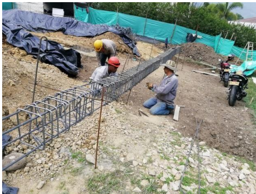
Fotografía 12. armada de refuerzos de vigas
