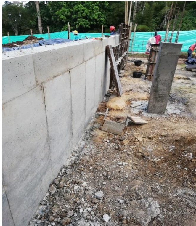
Fotografía 19. desencofrada de muro
