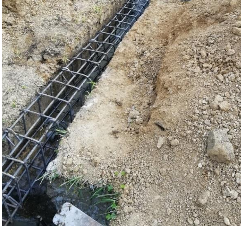
Fotografía 13. vigas de cimentación
