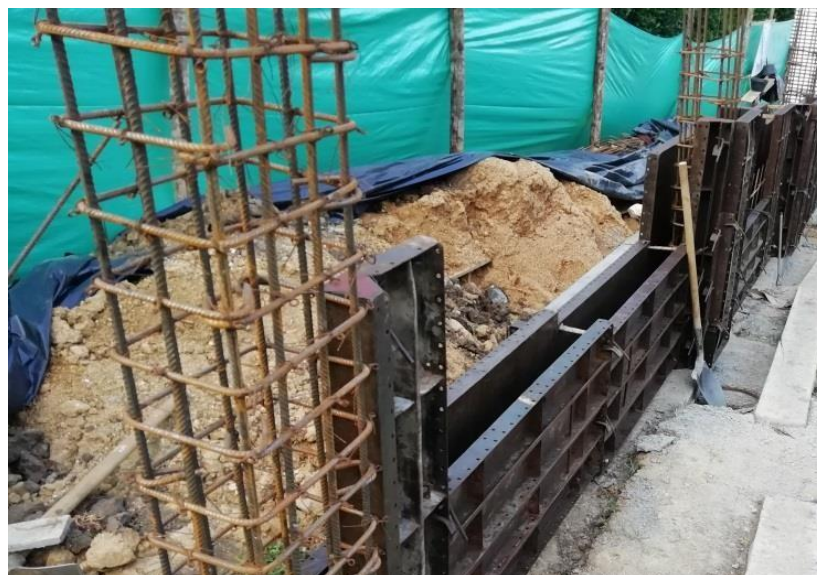
Fotografía 17. formaletas para muro y columnas
