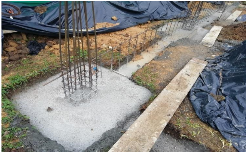
Fotografía 15. fundida de base de columna y viga de cimentación
