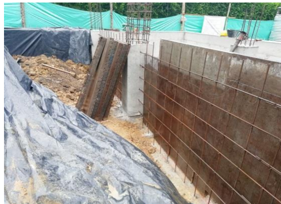
Fotografía 20. desencofrada de muro y columna
