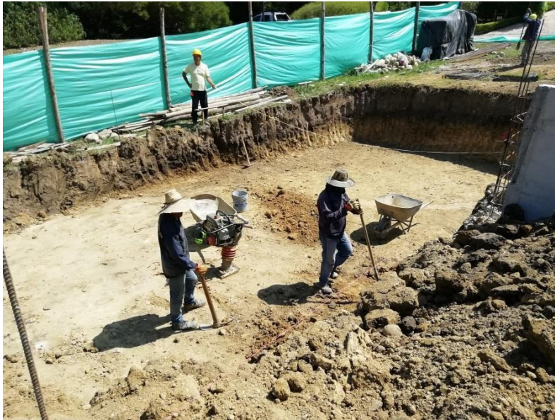
Fotografía 25. excavación terminada por obreros
