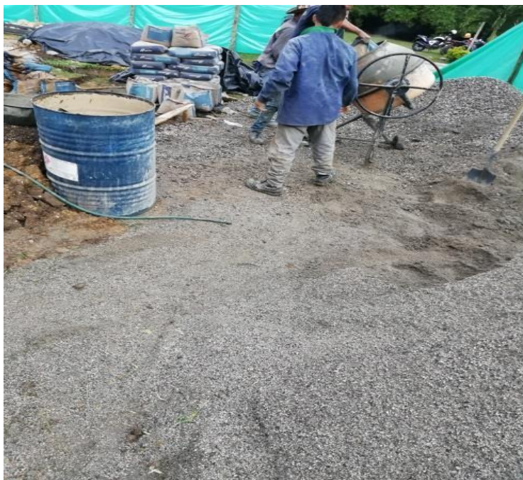
Fotografía 14. mezcla de concreto
