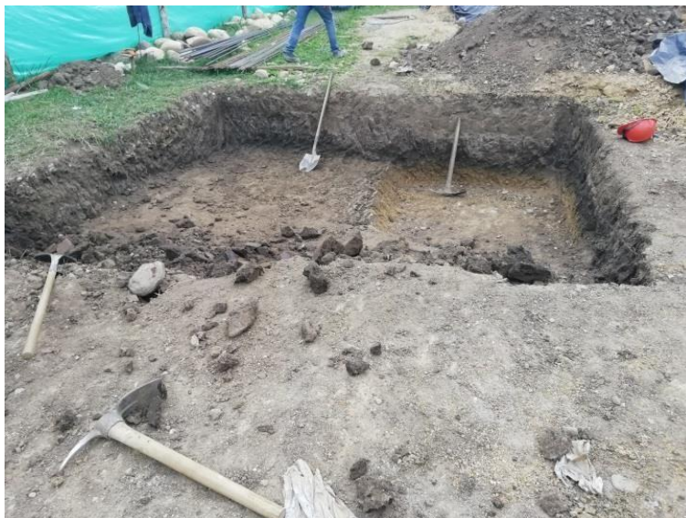
Fotografía 23. Excavación inicial hecha por obreros
