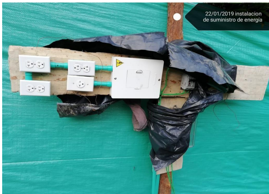
Fotografía 3. Instalación de suministro de energía
