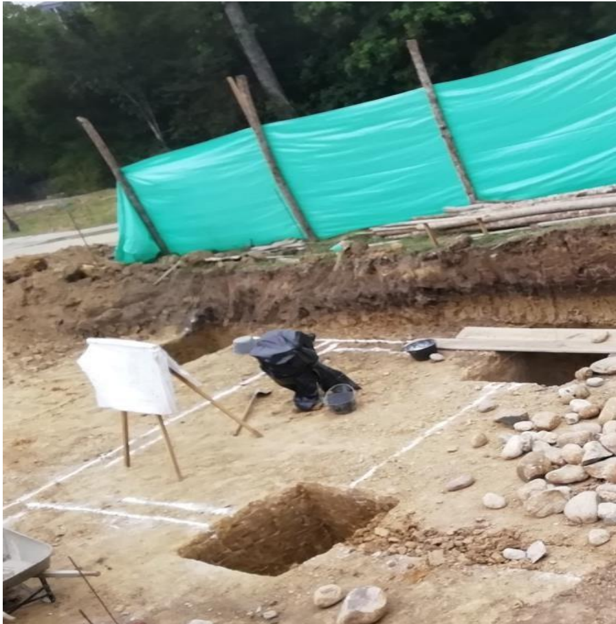
Fotografía 5. excavaciones de zapatas
