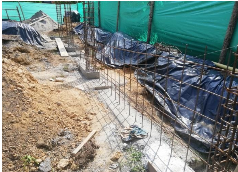
Fotografía 16. refuerzo para columna y muros
