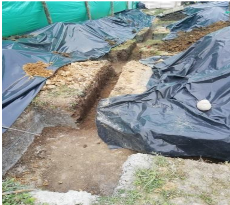
Fotografía 7. excavaciones de vigas de cimentación
