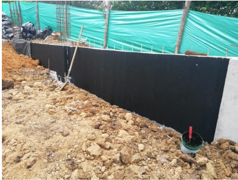
Fotografía 21. muro impermeabilizado
