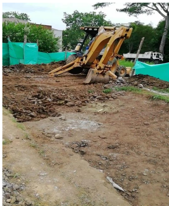
Fotografía 24. Excavación con retroexcavadora
