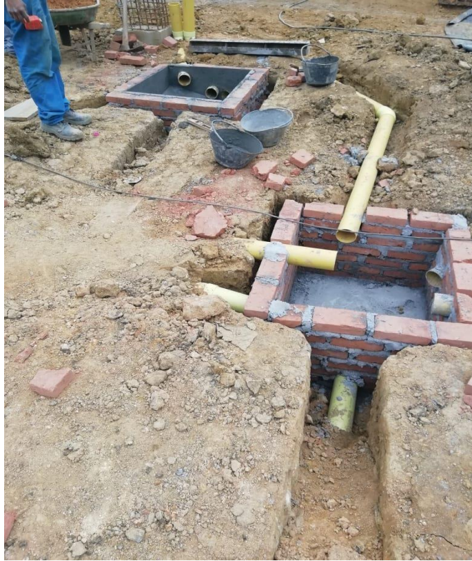
Fotografía 32. caja de inspección
