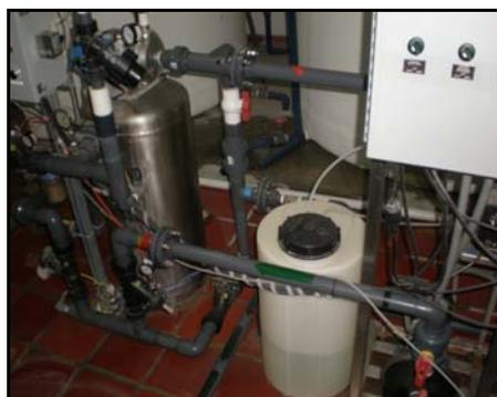
**Figura 13.** Tanque de Cloro y Sistema de Suministro. [1]
