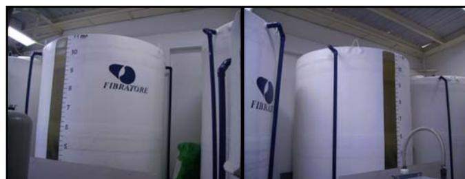
**Figura 14.** Tanques de Almacenamiento de Agua Clorada y Ultrafiltrada. [1]
