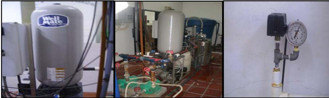
**Figura 15.** Sistema Hidroneumático, Bomba de Desplazamiento Positivo y Sensor de Presión. [1]
