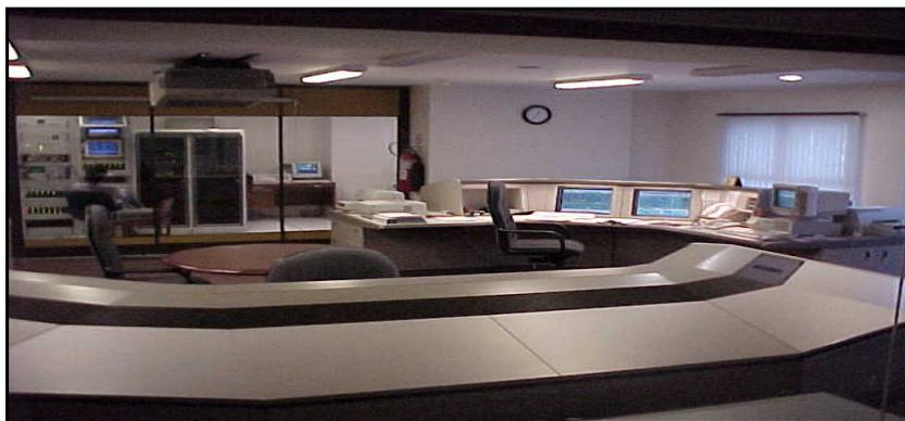
**Figura 36.** Centro de Operaciones de un Sistema SCADA. [6]
