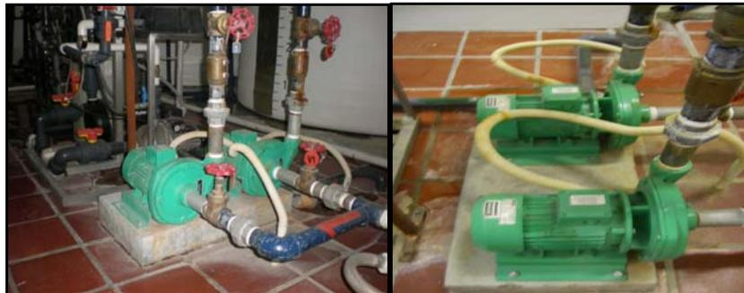
**Figura 10.** Bombas Impulsoras con Válvula Check. [1]
