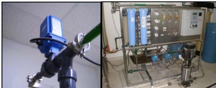
**Figura 28.** Válvula de Lavado y Válvulas de Recirculación. [1]
