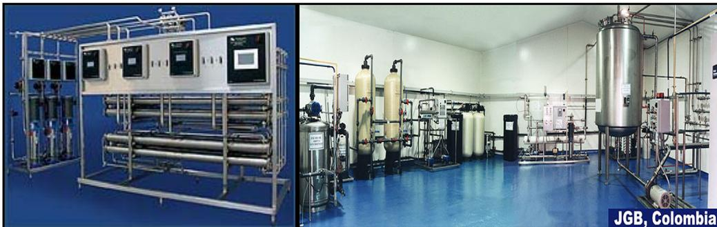
**Figura 7.** Planta de Osmosis de 24 Membranas y Planta de Osmosis Modelo Clearwater en la Empresa JGB Colombia. [13]
