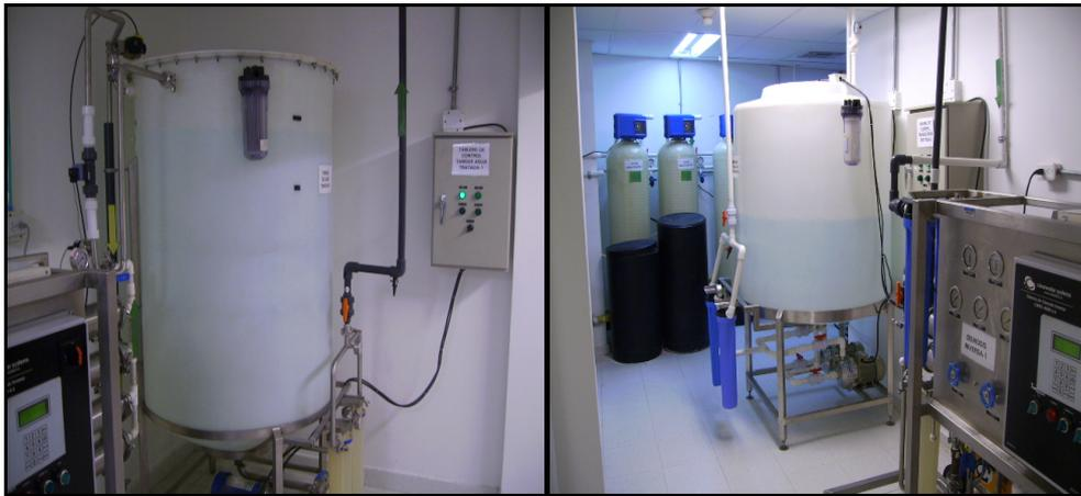
**Figura 29.** Tanques de Almacenamiento con Filtro de Aire y Bombas de Distribución en Paralelo. [1]
