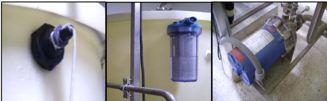
**Figura 30.** Sensor de Nivel, Filtro de Aire y Bomba de Distribución. [1]
