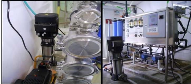
**Figura 23.** Bomba Multietapa de Alta Presión y Sistema de Osmosis. [1]
