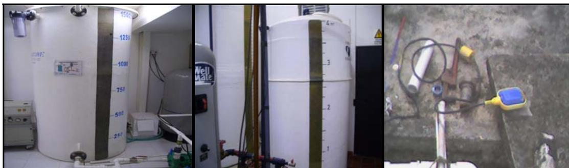
**Figura 8.** Tanques de Almacenamiento y Sensor de Nivel Tipo Flotador. [1]
