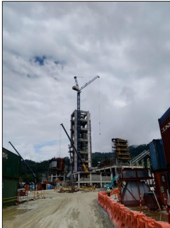
Figura 17. Grúa abatible LCL 500, Obra: Cemex – Antioquia. Fuente: Gigacon Transportes S.A.S.
