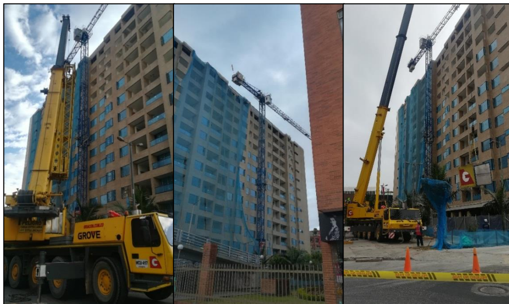
Figura 22: Desmontaje de torre grúa COMANSA 5LC 5211, Bogotá D.C. Fuente: Gigacon Transportes S.A.S.
