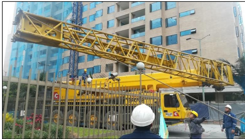
Figura 23. Descargue de piezas torre grúa COMANSA 5LC 5211, Bogotá D.C. Fuente: Autor.
