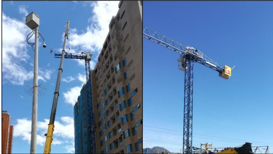
Figura 6: Contrapluma EC5 – 01. Fuente: Autor.
