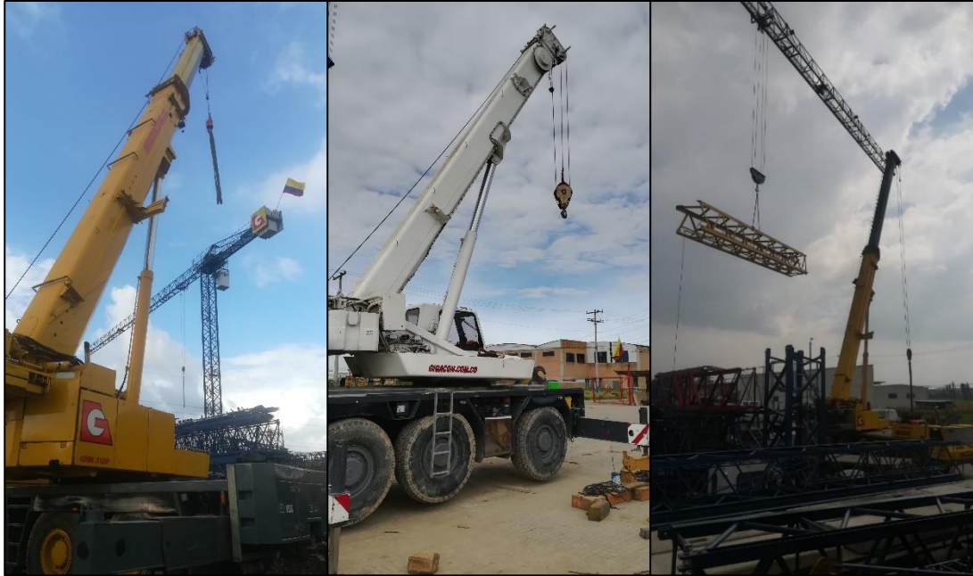
Figura 19. Grúas telescópicas en Planta – Cota, Gigacon Transportes S.A.S. Fuente: Autor.
