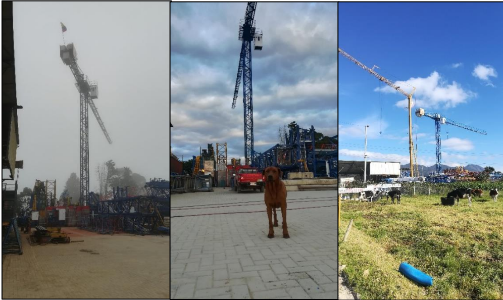
Figura 2: Torre grúa 5LC 5010. Fuente: Autor.
