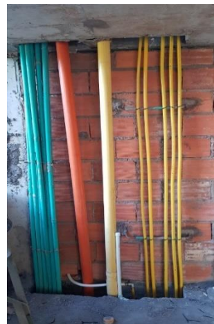
imagen 3 Instalación de tubería para bajantes sanitarias
