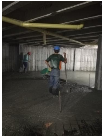
imagen 4 Fundida de placa de contrapiso
