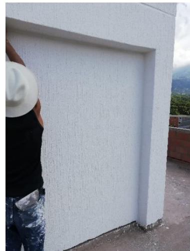
imagen 38 Graniplast en la cubierta
