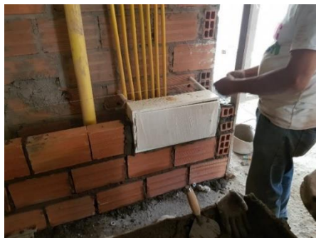
imagen 2 Instalación de domiciliaria potable
