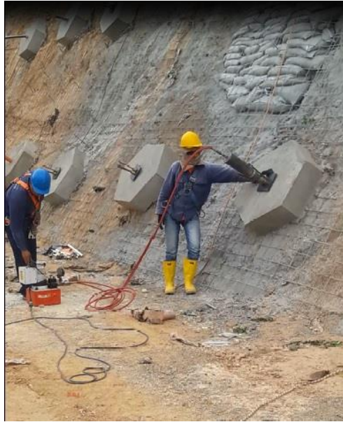
Imagen 18. Tensionamiento anclajes proyecto Bellavista
