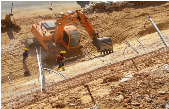
Imagen 12. Perfilado de talud a máquina. (Elaboración propia)
