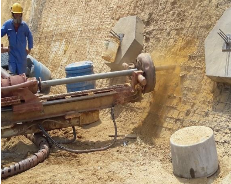
Imagen 15. Perforación para la instalación de geodrenes
