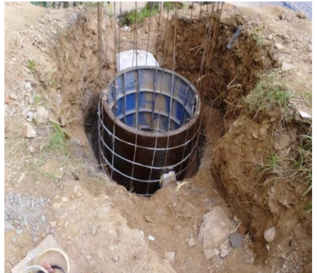
Imagen 14. Pozos verticales pata de talud
