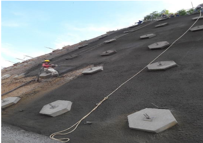
Imagen 19. Concreto lanzado proyecto Bellavista.
