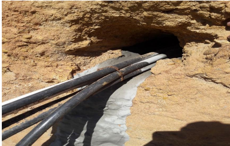
Imagen 20. Reinyección anclajes, presión 150 psi – 1.03 Mpa, Proyecto Bellavista
