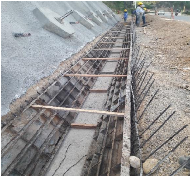
Imagen 13 Cuneta recolección de agua pata de talud
