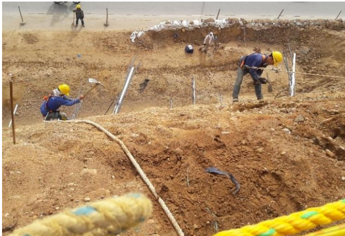
Imagen 11. Perfilado del talud, excavación a mano. (Elaboración propia)
