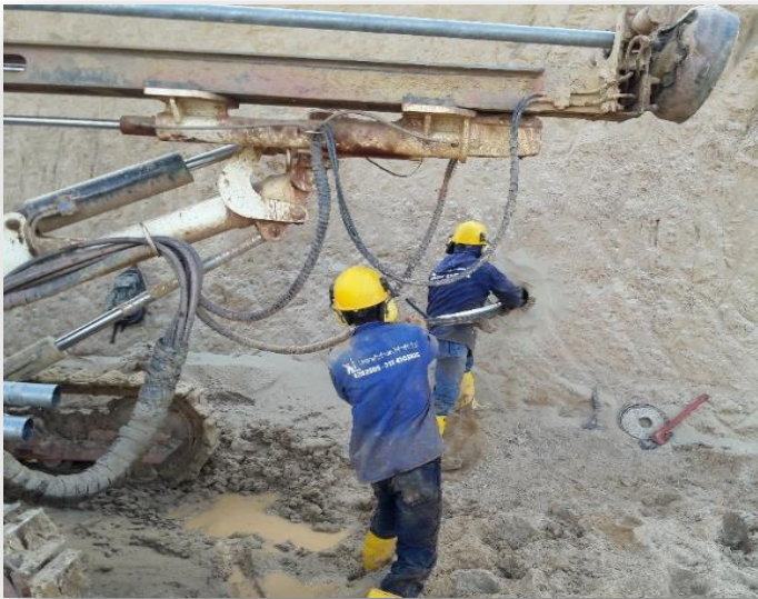
Imagen 9. Aplicación de método en proyecto, Bellavista- Incremento de esfuerzos aplicando fuerzas externas, perforación en instalación de anclajes. (Elaboración propia)
