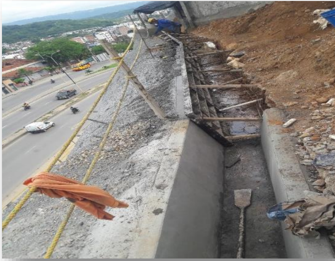
Imagen 8. Aplicación de método en proyecto Bellavista. Reducción de fuerzas desestabilizadora, Cuneta de corona. (Elaboración propia)
