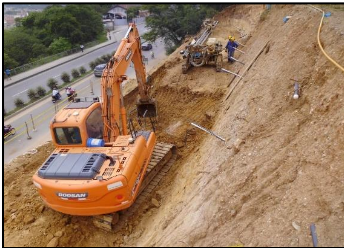
Imagen 10. Movimiento de tierra para la eliminación de masa inestable. (Elaboración propia)
