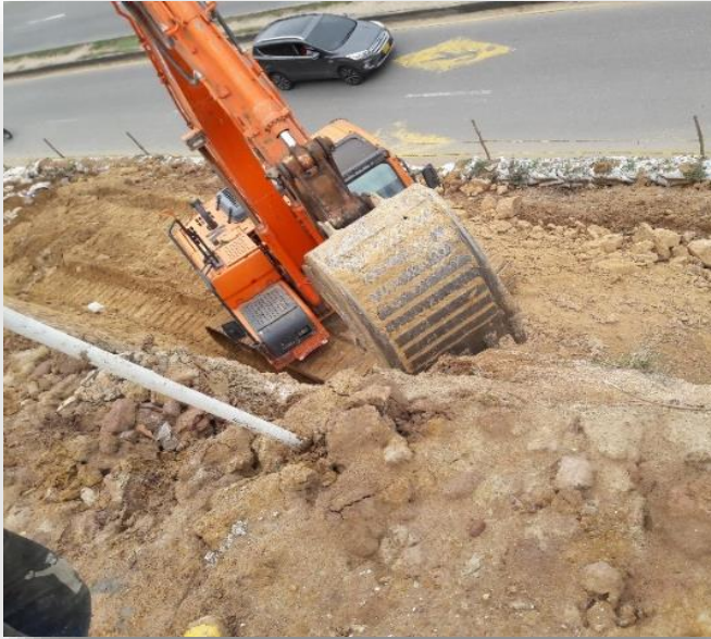
Imagen 6. Aplicación de método en proyecto Bellavista. Reducción de fuerzas desestabilizadoras, cambio de pendiente. (Elaboración propia)
