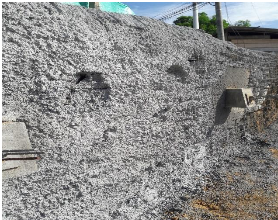
Imagen 36. Adherencia nula o deficiente de material por uso de aditivo no apto para el lanzado
